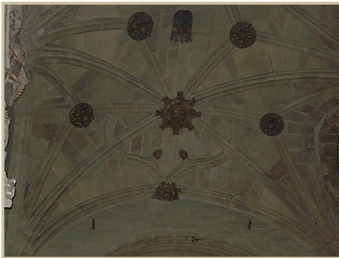
Obr.155 Zaklenutí presbyteria kostela svatého Kříže (Santa Cruz v Coimbře, Diogo Boytaca
