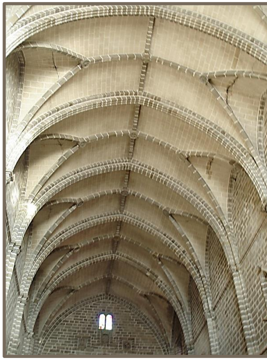
Obr.125 Klenba a část interiéru kostela sv. Františka
