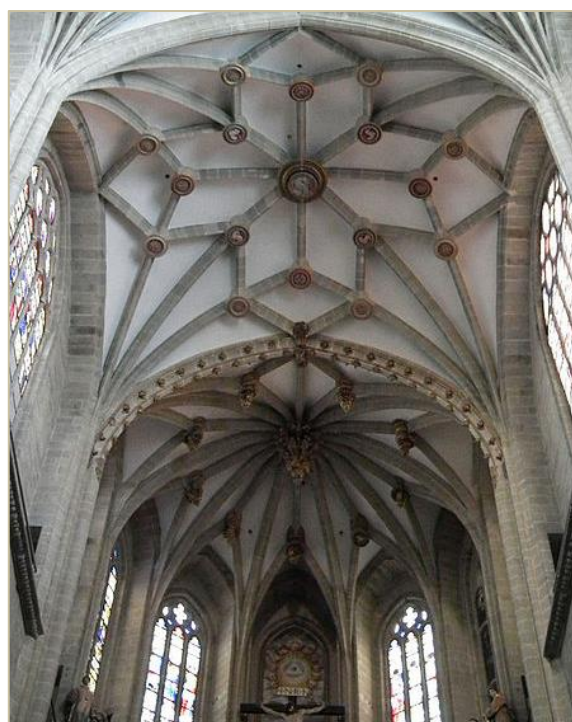
Obr.182 Klenební vzorec, katedrála v Astorze, ? Juan de Colónia
