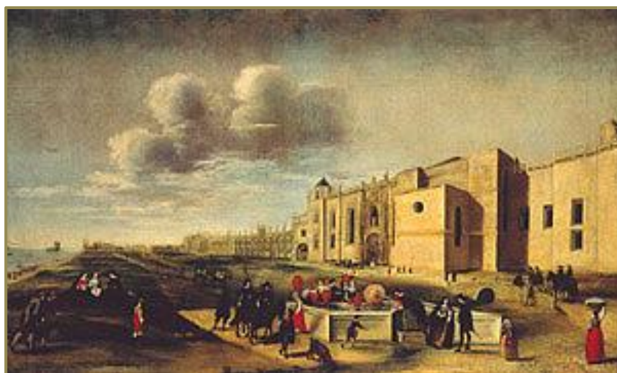
Obr.52 Jeronýmský klášter-jižní průčelí, Filipe Lobo, 1657
