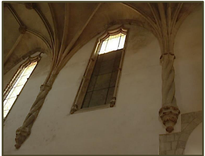
Obr.41 Tordované polopřípory, klášterní kostel svatého Kříže (svatého Kříže), Coimbra
