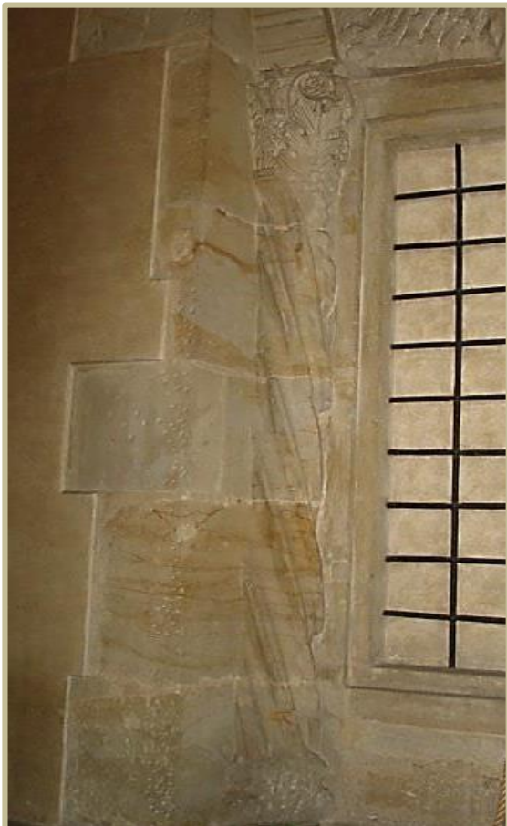
Obr.42 Efekt tordování vytvořený obtáčením prutů, Vladislavský sál, Starý královský palác, Praha
