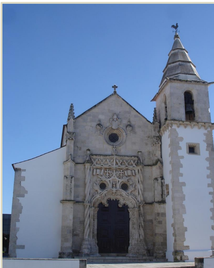
Obr.218 Průčelí s manuelským portálem, farní kostel Panny Marie, Golega, ? stavitel D.Boytaca
