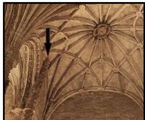
Obr.62 Detail klenby transeptu - druhá klenební přípora nenavazující na klenební vzorec
