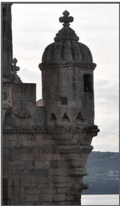
Obr.138 Detail dekorace nárožní vížky završené kupolí s pasy
