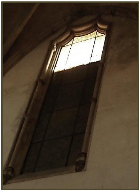
Obr.77 Záclonové okno, loď kostela sv. Kříže, Coimbra, Diogo Boytaca, kolem r.1510)
