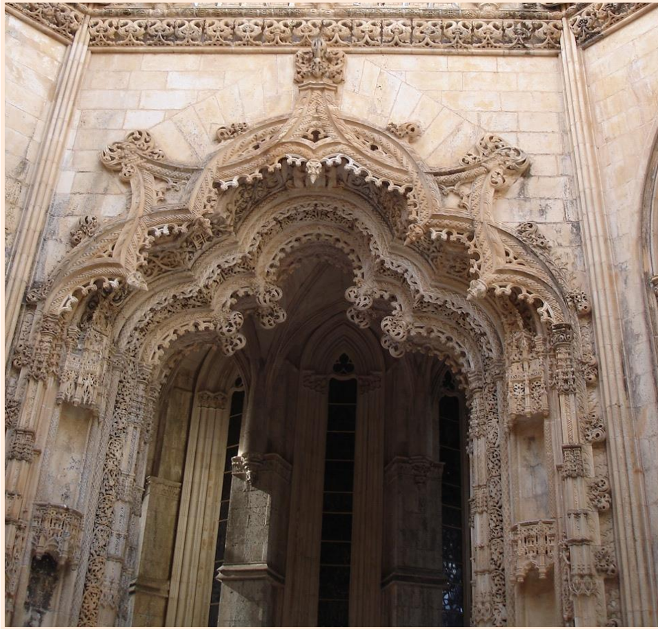
Obr. 97 Manuelský portál Nedokončené kaple
