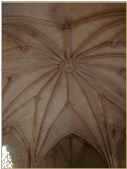
Obr. 149 Zaklenutí kapitulní síně hvězdovou klenbou bez použití centrálního pilíře, klášter Batalha, mistr Huguet
