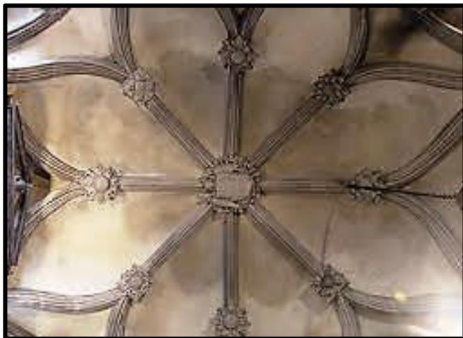
Obr.190 Klenební vzor osmicípé hvězdice s krouženými žebry, kostel Nossa Senhora de Pópulo, Caldas da Rainha, Mateus Fernandes
