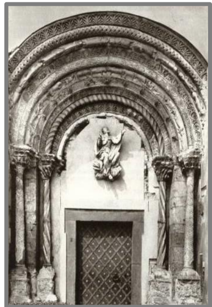
Obr.37 Tordování dřívků u portálu, kostel sv. Prokopa, Záboří nad Labem
