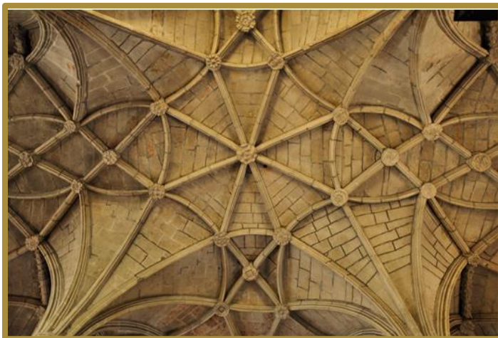
Obr.59 Detail klenebního vzorce v lodi
