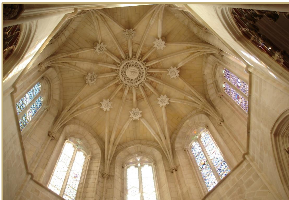
Obr.148 Osmicípá hvězdová klenba v Kapli zakladatele v klášteře Batalha, stavitel mistr Huguet
