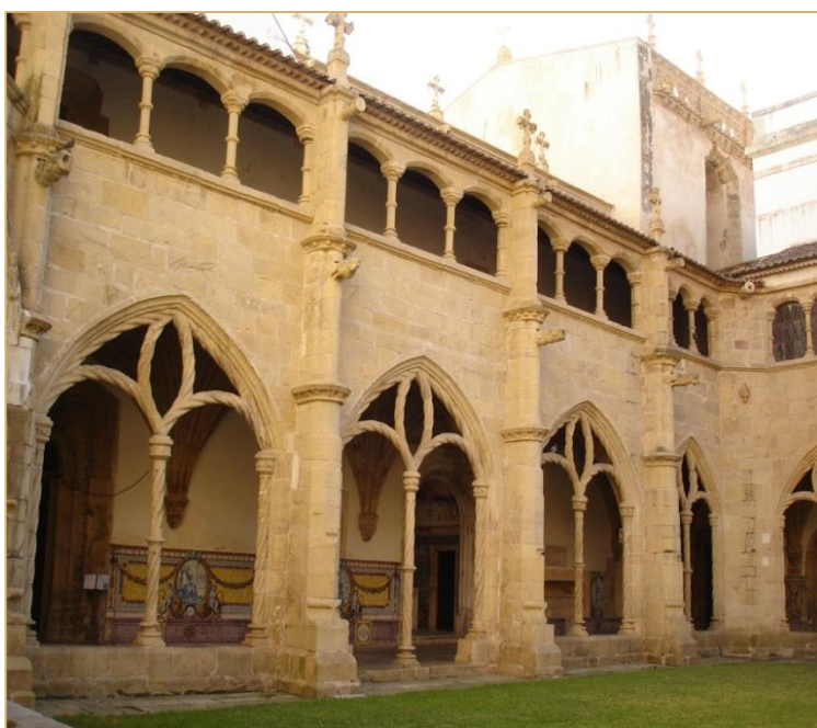
Obr.81 Ambit kláštera sv. Kříže s výrazným tordováním použitým v arkádách v přízemí ambitu
