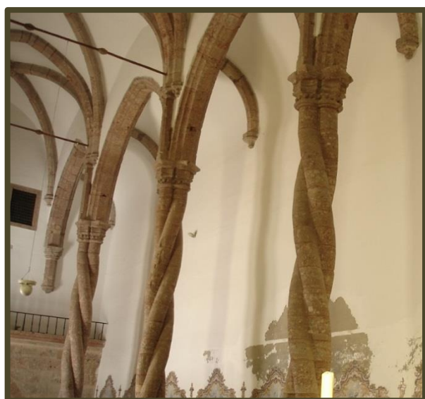
Obr.30 Loď Ježíšova kostela - detail 3 pilířů se vždy 3 vzájemně stáčenými dřívky
