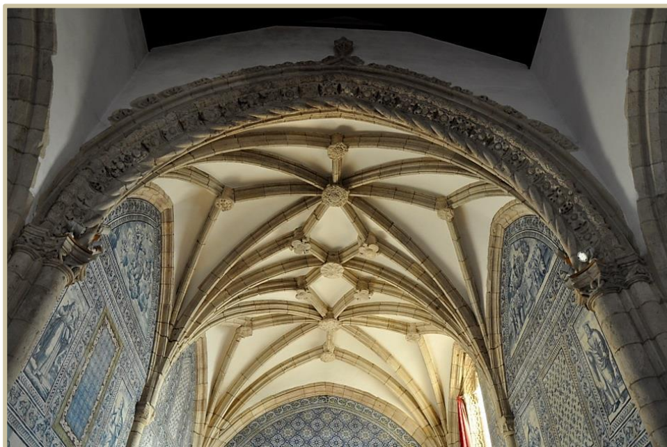
Obr.154 Zaklenutí presbyteria hvězdovou klenbou ve farním kostele v Goleze, připisované Diogovi Boytacovi
