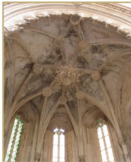
Obr.150 Hvězdová klenba v jedné z obvodových kaplí v Nedokončené kapli v klášteře Batalha
