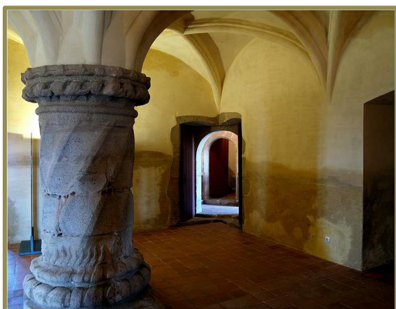
Obr.145 Interiér sálu, detail torčovaného pilíře
