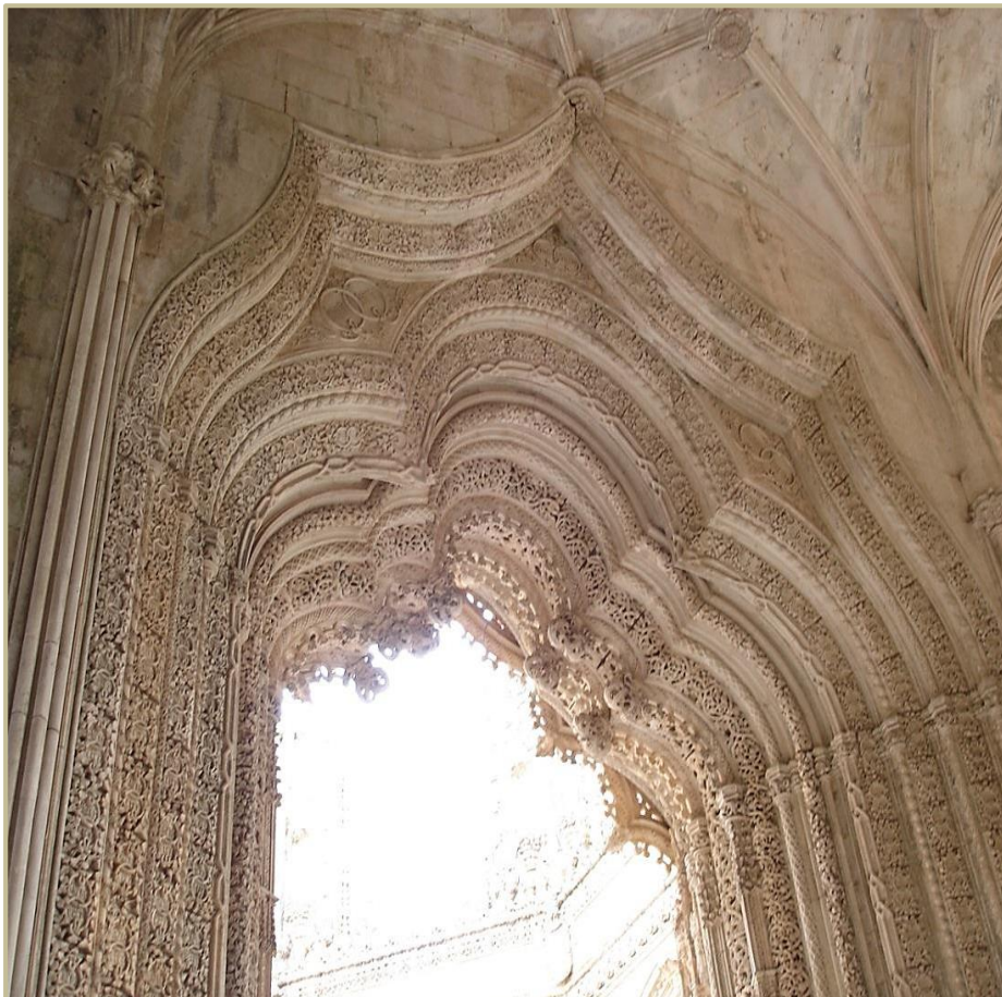
Obr. 98a Portál do Nedokončené kaple - záclonový tvar doplněný laloky, pohled z předsíně
