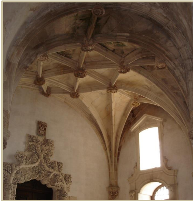
Obr.161 Klenební vzorec s vloženým žebrovým prstencem v předsíni u Nové sakristie, klášter Alcobaca, João de Castilho
