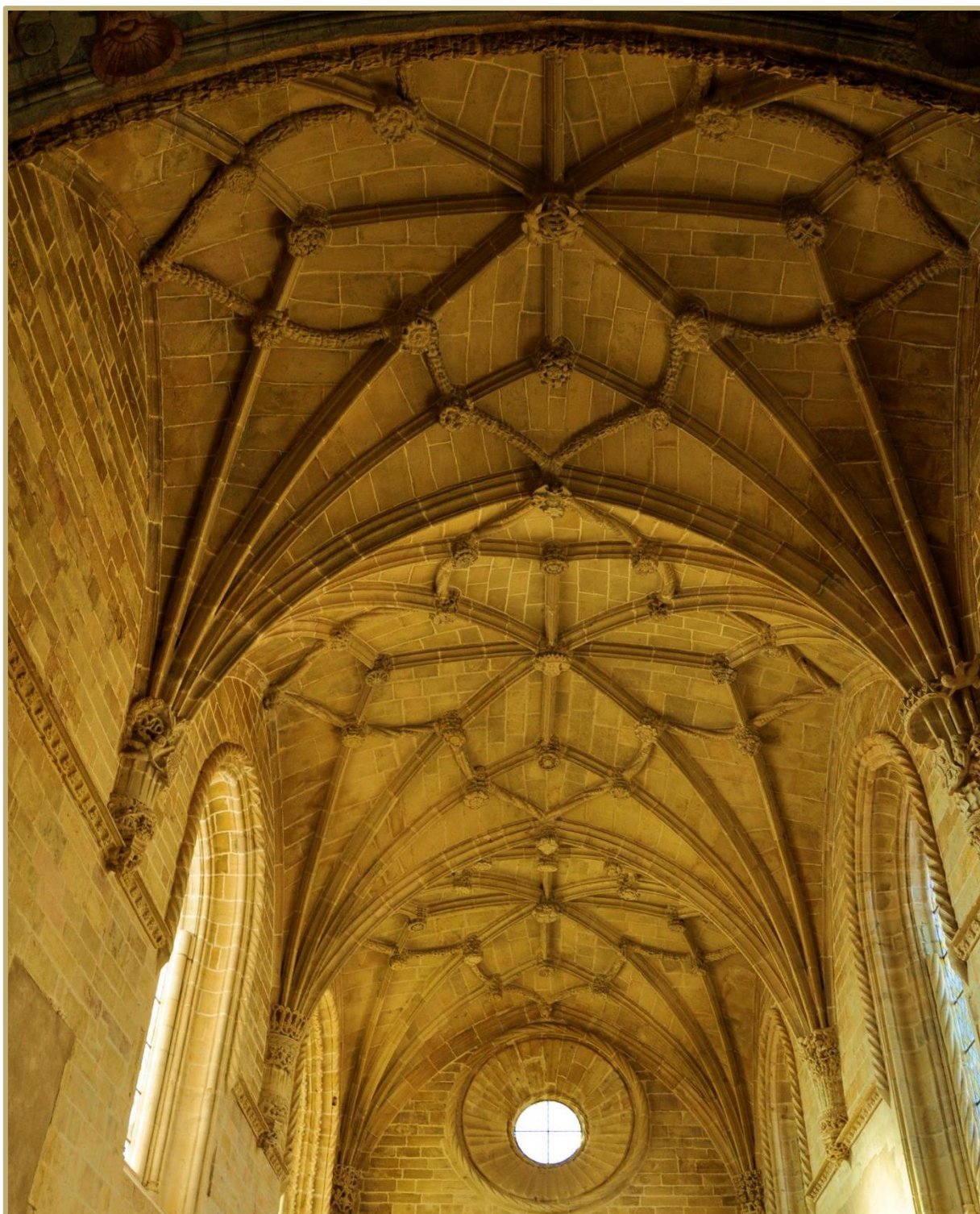
Obr. 186 Zaklenutí klášterního kostela řádu Kristova v Tomaru, tzv. listy v této obrazcové klenbě mají v každém klenebním poli jiným způsobem formovaná žebra - do podoby provazu tordováním či do podoby rostlinných úponků. Stavitelem byl João de Castilho.
