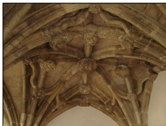
Obr.82 Detail zaklenutí rohového pole ambitu
