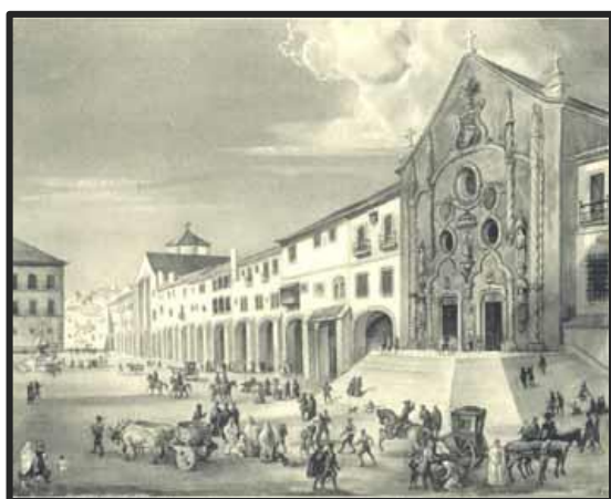
Obr. 21 Nemocnice Todos-os-Santos, západní průčelí, zpevněné opěráky patrně kvůli zemětřesení, která jsou doložena i v 16. století.
