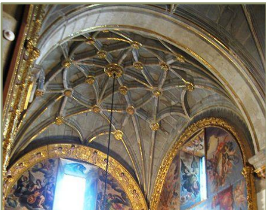
Obr.176 Složitější typ obrazcové klenby s vloženým žebrovým prstencem, Metropolitní katedrála Asunción de la Virgen María, Ciudad de México
