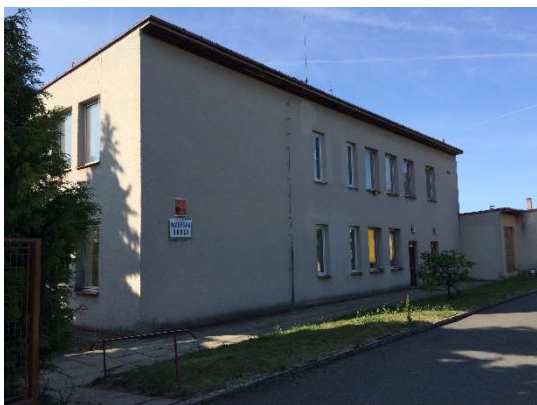
Obrázek 10: Foto MŠ Bělčice před rekonstrukcí [14]
