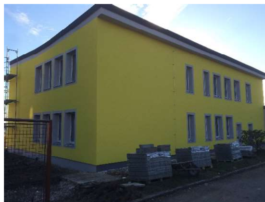
Obrázek 11: Foto MŠ Bělčice po rekonstrukci
