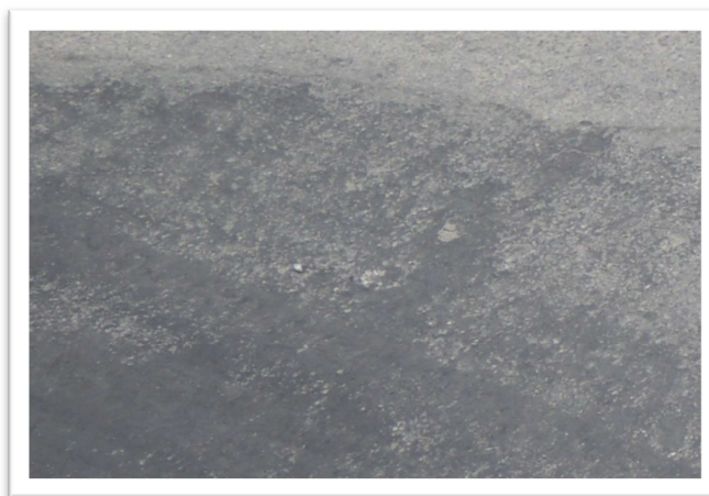
Obrázek 3.4: Ztráta makrotextury (zdroj: foto autor)
