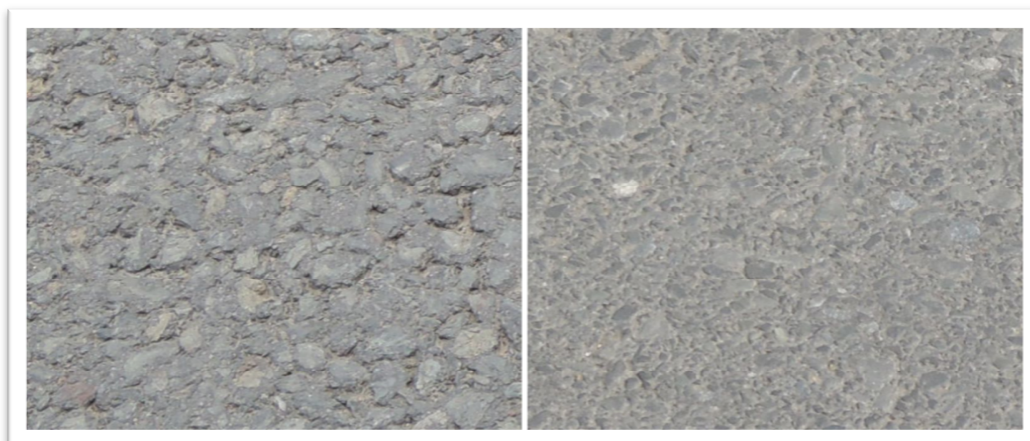
Obrázek 3.3: Ztráta mikrotextury (zdroj: foto autor)
