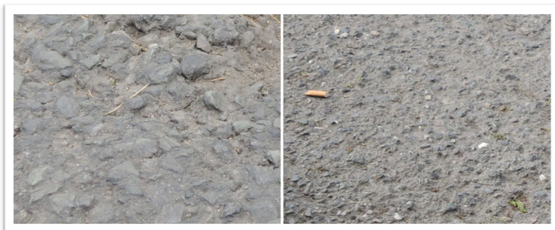
Obrázek 3.5: Ztráta asfaltového tmelu a kaverny (zdroj: foto autor)
