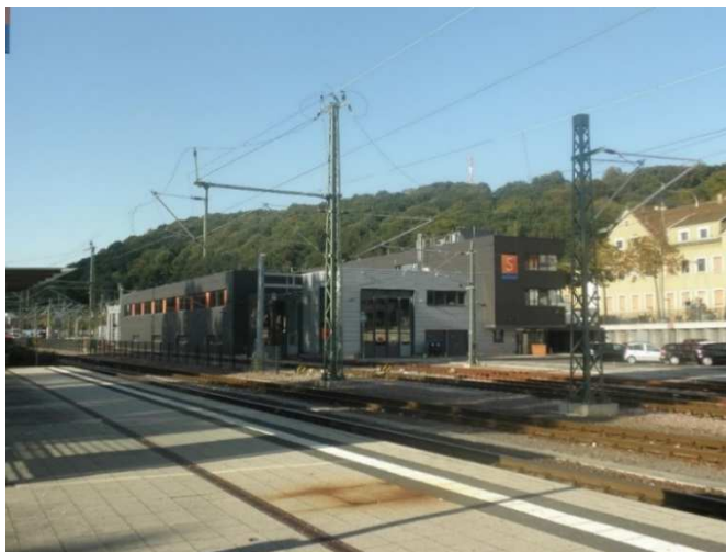
Obrázek 12: Vozovna vozidel Tram - train ve stanici Brebach zprovozněna v r. 2012
