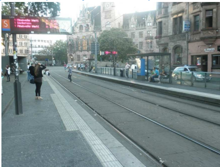
Obrázek 15: Vysoká nástupiště zastávky Johanneskirche TT trati v centru Saarbrücken (výška nástupní hrany 35 cm nad TK)
