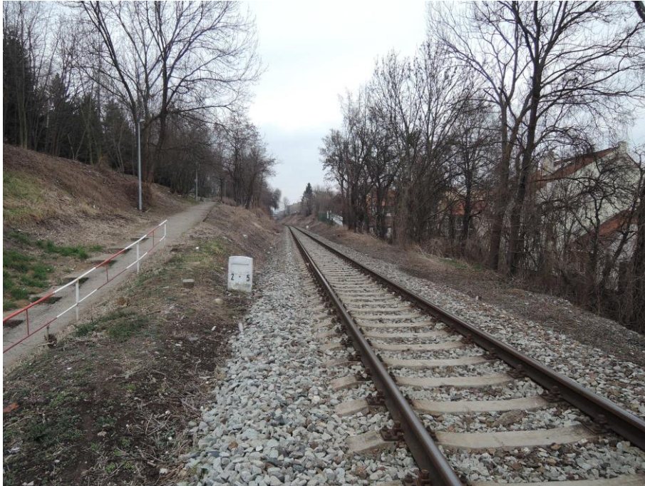
Obrázek 14: Pohled z viaduktu nad ulicí Nad Zlíchovem směrem na Smíchov
