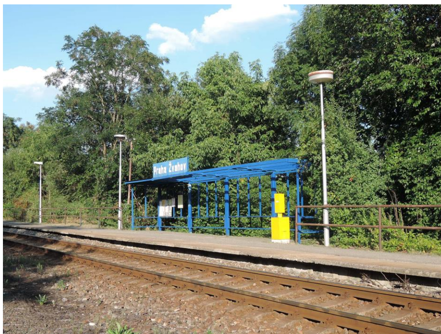
Obrázek 3: Praha-Žvahov – přístřešek a nástupiště u používané koleje
