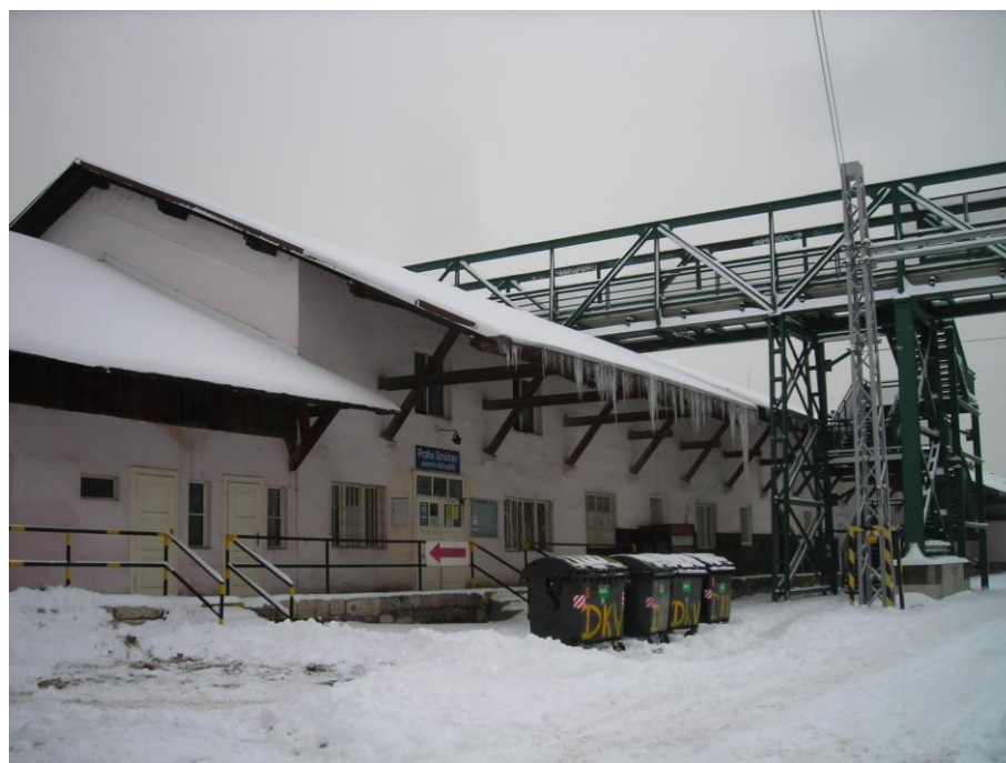
Obrázek 2: Staniční budova Praha-Smíchov severní nástupiště
