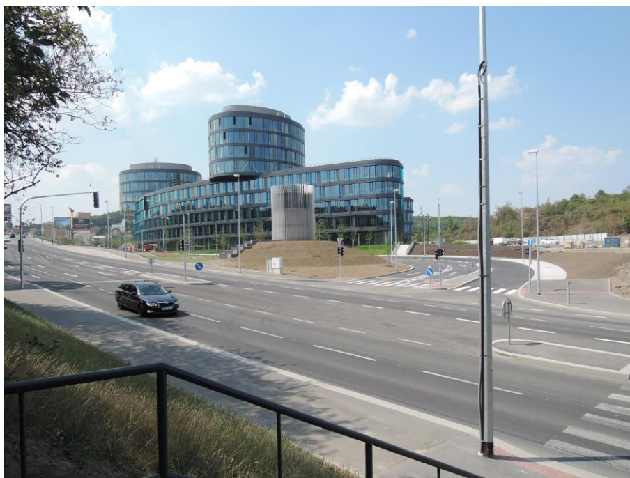
Obrázek 21: Pohled od přechodu od železniční stanice na budovu Aviatica
