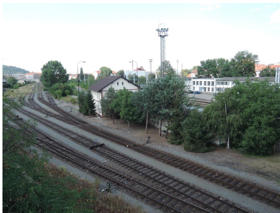
Obrázek 12: Pohled z lávky směrem k zastávce Na Knížecí na stavědlo a místo navrženého nástupiště
