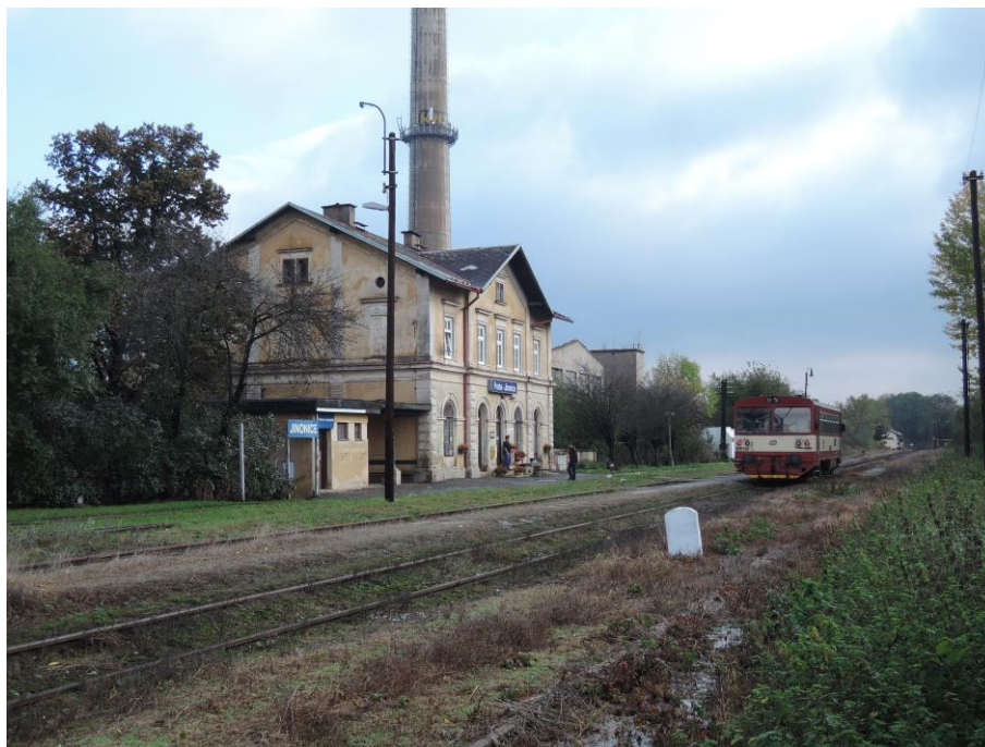
Obrázek 4: Železniční stanice Praha-Jinonice s Os 25911
