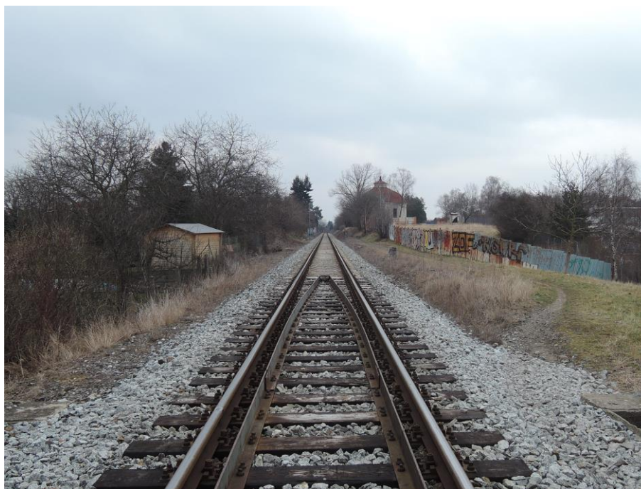
Obrázek 31: Pohled z mostu ke kapli (směr Smíchov)
