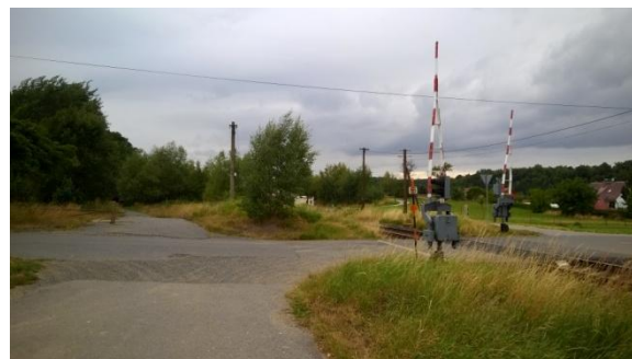
Obr.31 a 32: Výstražník není viditelný z vedlejších komunikací (zdroj: foto autora)
