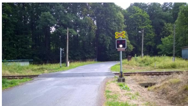
Obr. 23: Retroreflexní podklad výstražného kříže (zdroj: foto autora)
