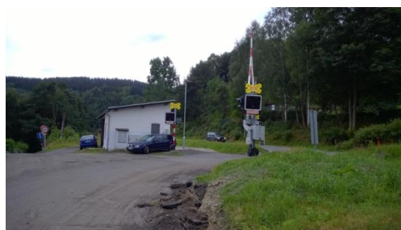
Obr.25 a 26: Přejezd chrání závory a celkem 5 výstražníků (zdroj: foto autora)
