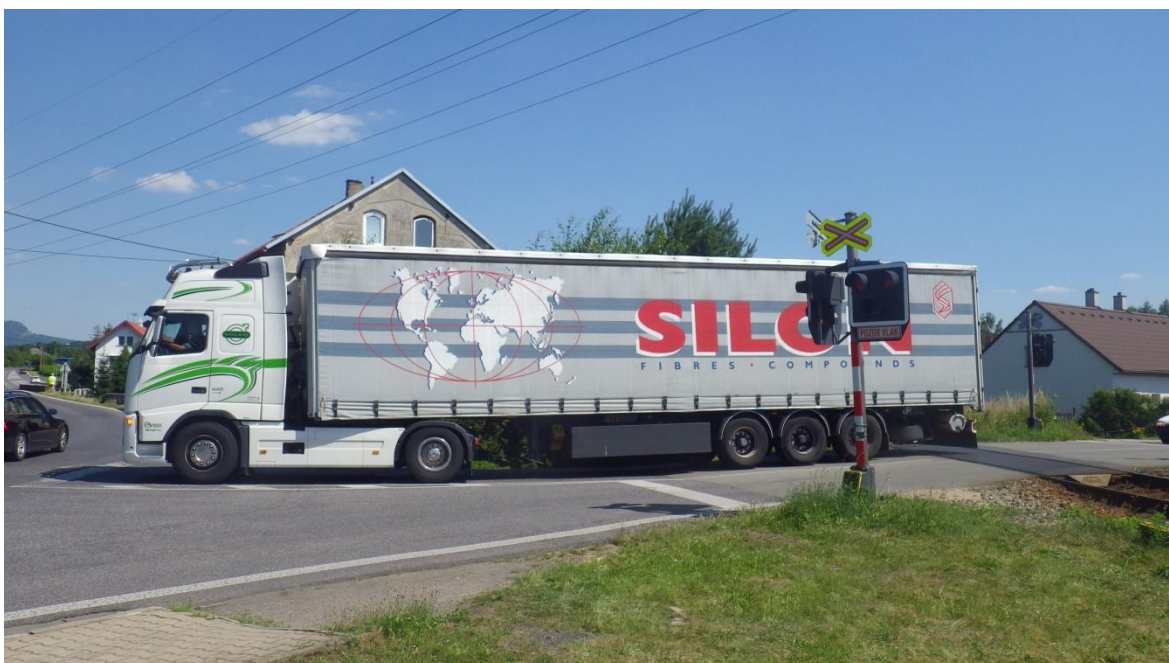
Obr. 6: Nedostatečná vzdálenost přejezdu od křižovatky (zdroj: foto L. Žídek)
