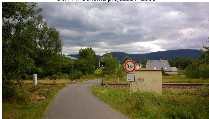
Obr. 15: Chybějící příčné opatření (zdroj: foto autora)
