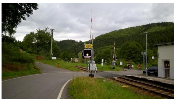
Obr.25 a 26: Přejezd chrání závory a celkem 5 výstražníků (zdroj: foto autora)
