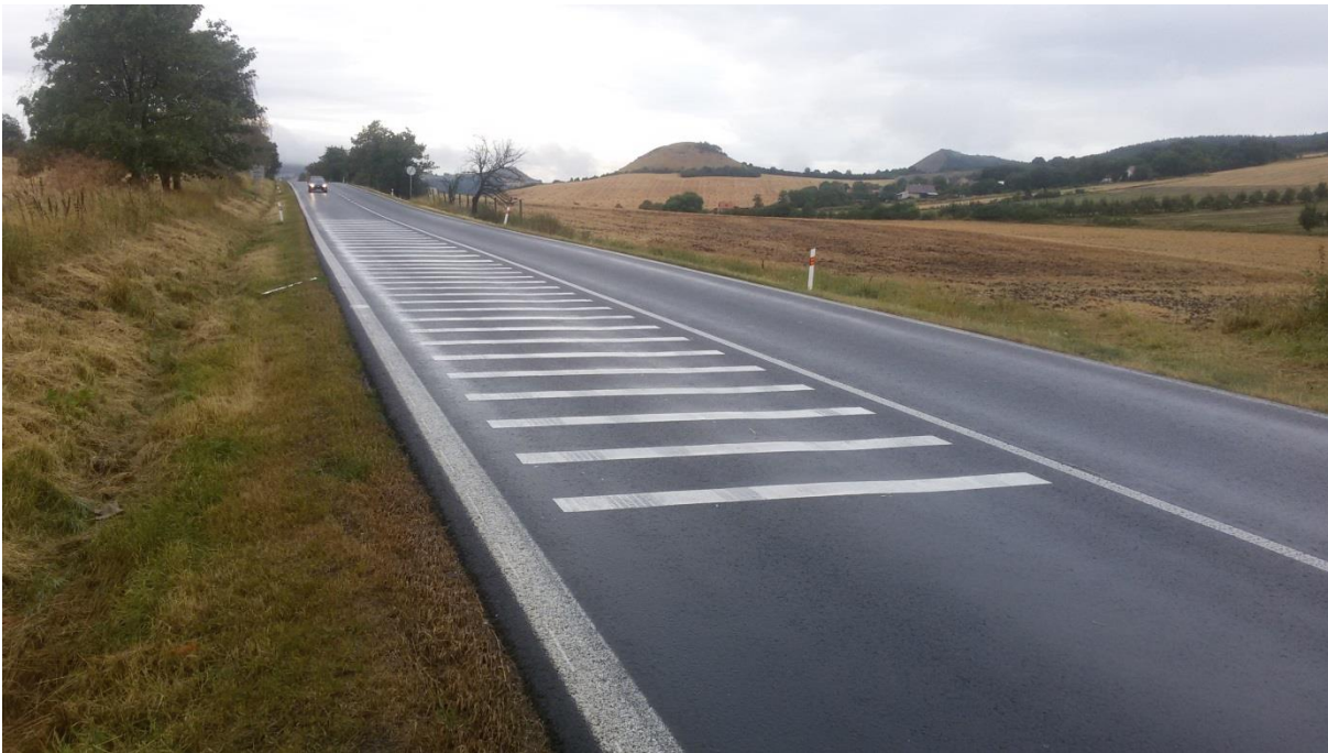
Obrázek 11: Opticko-psychologická brzda na západním vjezdu do zatáčky
