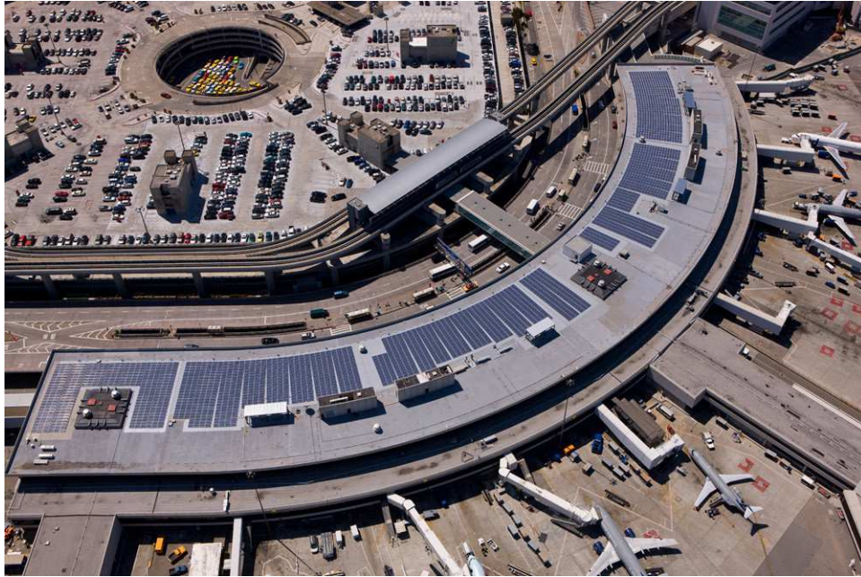
Obrázok 9: Solárne články na streche terminálu na letisku San Francisco international airport s výkonom 600 kW [20]
