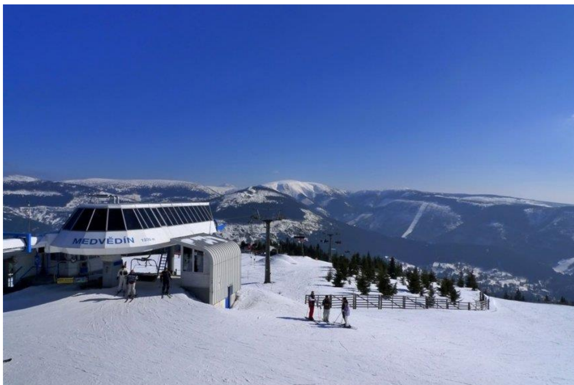
Obr. 16 Horní stanice lanové dráhy Medvědí [13]
