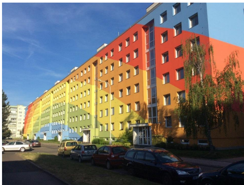
Obrázek 7-1 Foto měřeného panelového domu v Praze Čimicích
