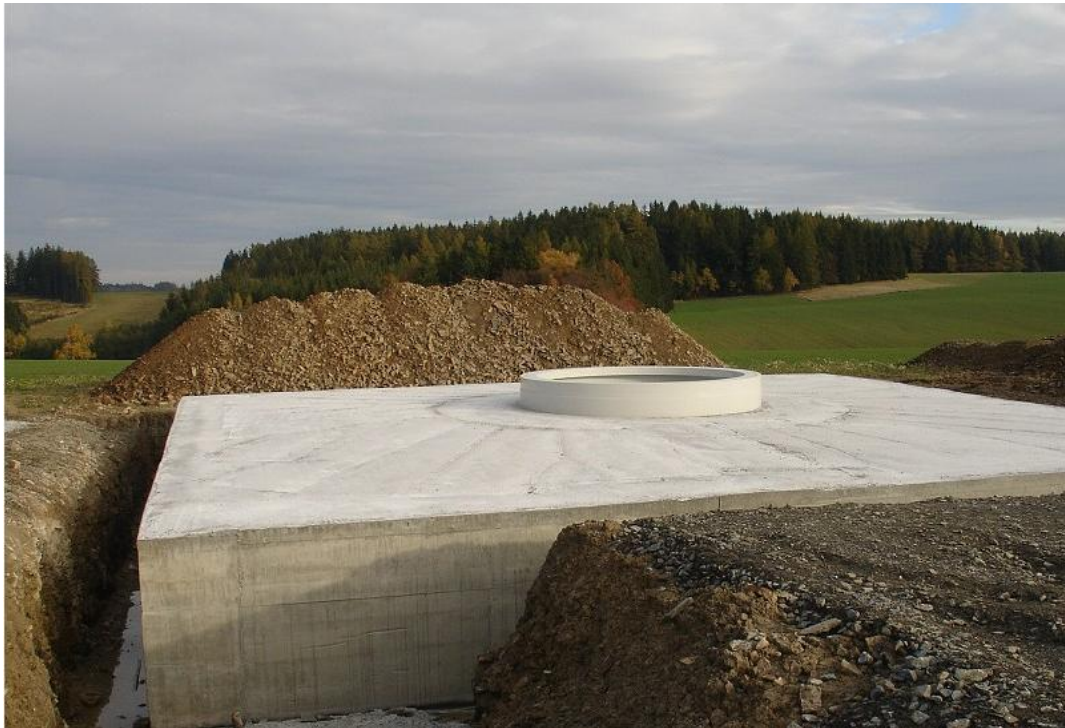
Obr. 3 - Hotový betonový základ větrné elektrárny (fundament ve středu betonu) 14
