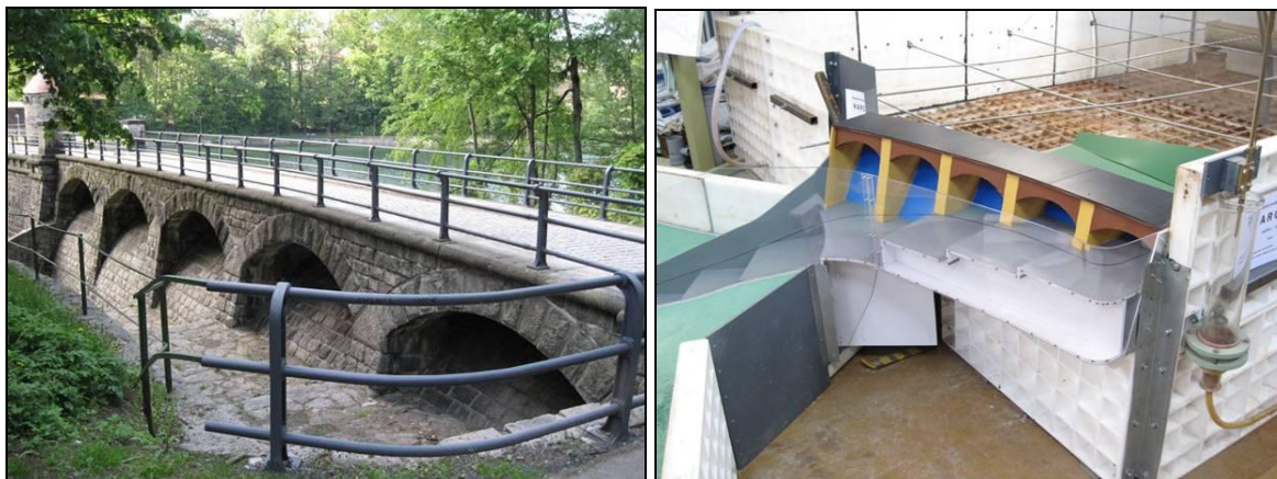
Obr. 4 Pohled na pět polí bezpečnostního přelivu s přemostěním ve skutečnosti a na hydraulickém modelu.
