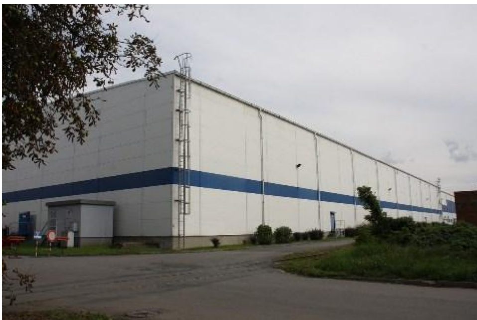
Obrázek 28: Venkovní pohled haly požáru rozvaděče (podle [XI.]
