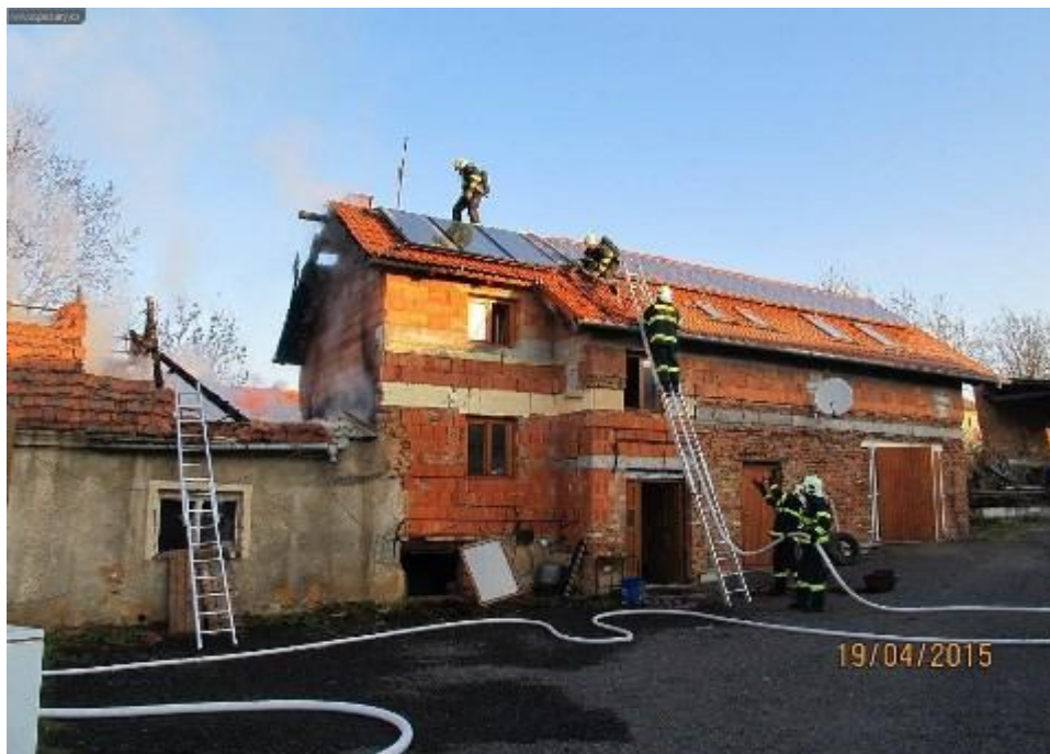
Obrázek 22: Celkový pohled požáru rodinného domu ve Šlovicích (podle [XL])
