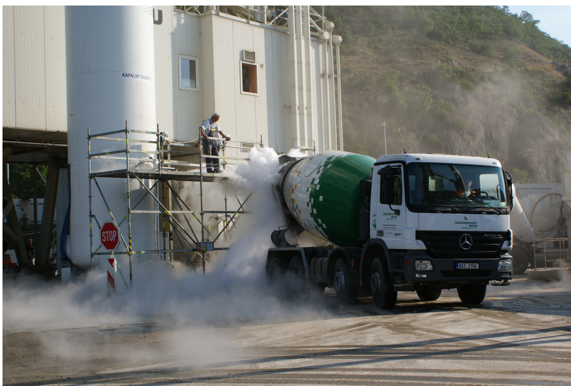
Obrázek 6.3 Chlazení čerstvého betonu kapalným dusíkem. Zdroj: (transportbeton.cz)
