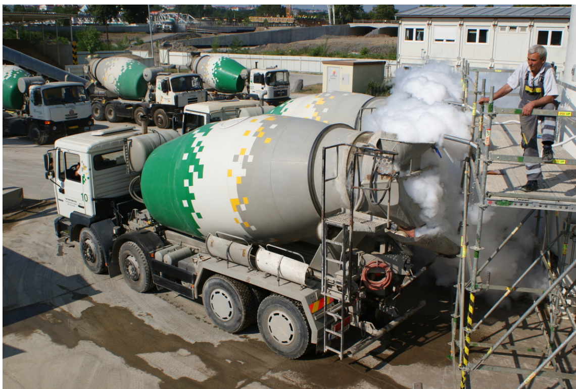
Obrázek 6.2 Chlazení čerstvého betonu kapalným dusíkem. Zdroj (VESELÝ et. al. , 2013)
