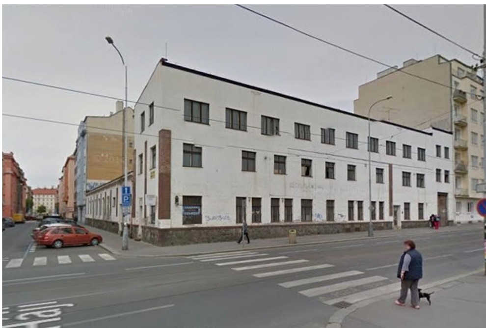
Obrázek 3 Stávající objekt z ulice Dělnická
