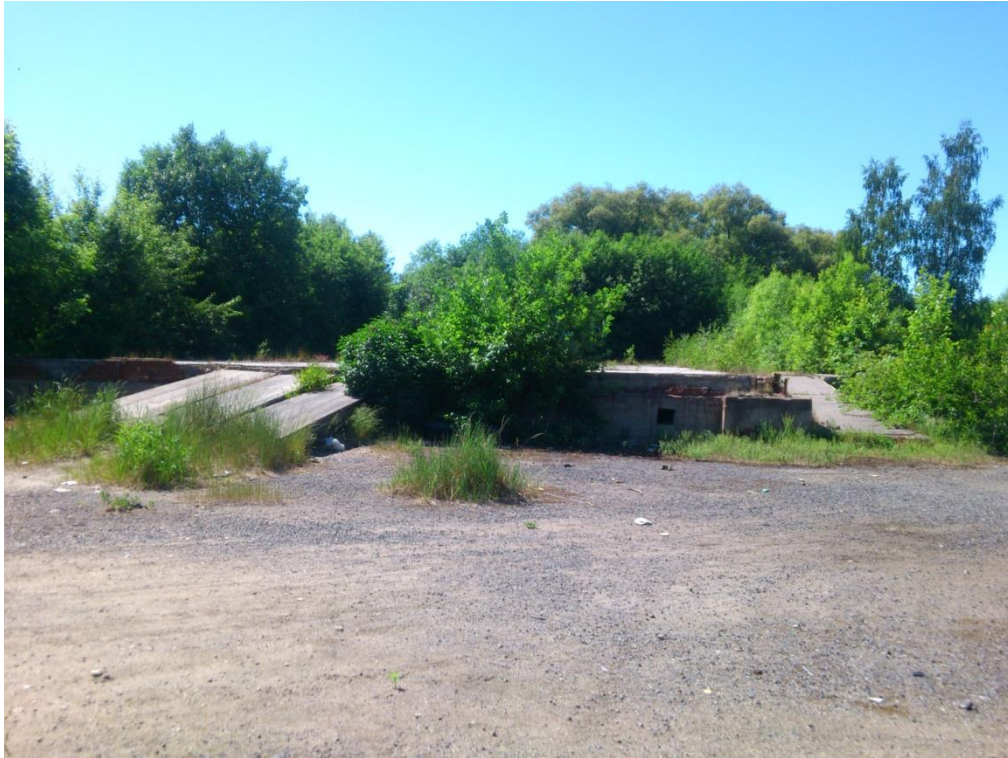
Obrázek 1: Fotodokumentace - stávající základové konstrukce demolovaných hal 2
