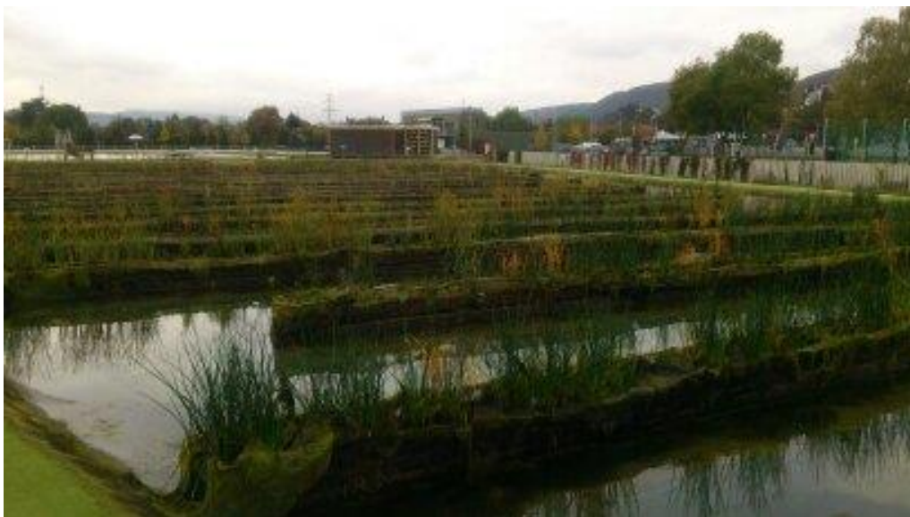
Obrázek 7: Fotodokumentace - přírodní koupací biotop Praha Radotín – systém průcezných hrázek 10
