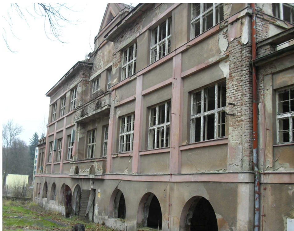
Obrázek 3: Jižní pohled na budovu A.
