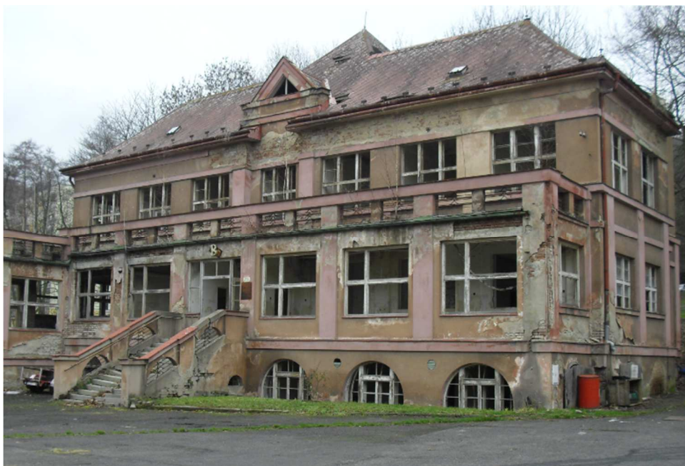
Obrázek 2: Pohled na budovu B.
