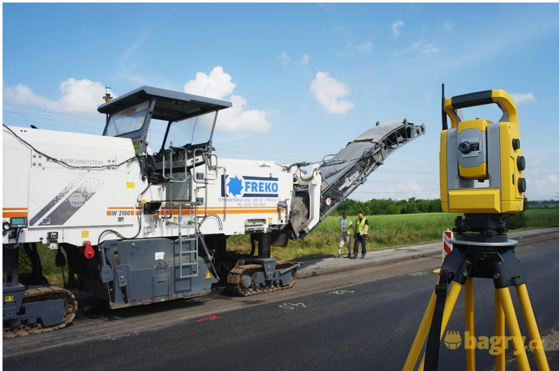
Obrázek 24 – Totální stanice Trimble GCS900 společnosti Sitech s frézou Wirtgen W2100
