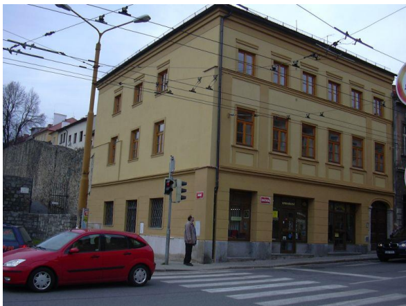
Obr. 3, Zrekonstruovaná fasáda domu Znojemská 18, Jihlava.
