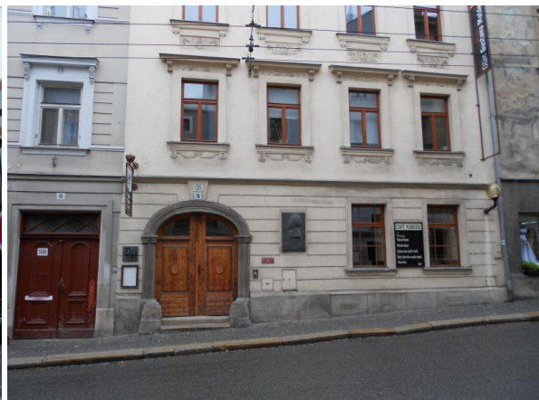
Obr. 4, Zrekonstruovaný dům Znojemská 4, Jihlava.
