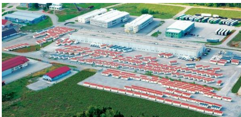
Obrázek 18: Skladovací plocha Sun Roller Slovinsko
