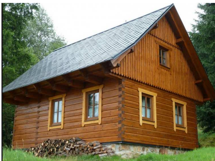
Obr. 15 Novostavba roubenky s rybinovým spojem
