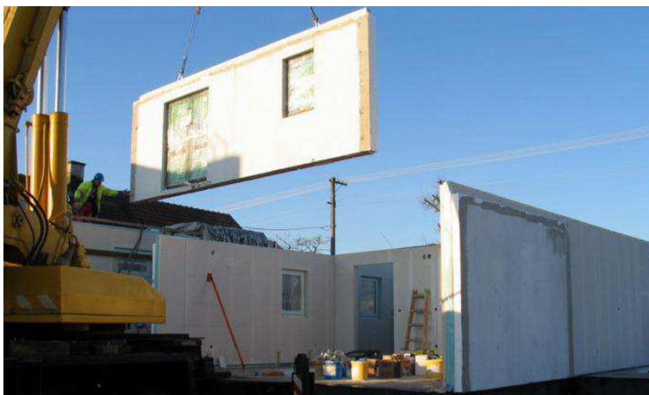
Obr. 17 Montáž prefabrikovaných panelů
