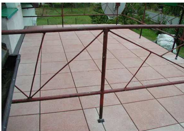
Obr. 27 Terasa na ploché střeše
