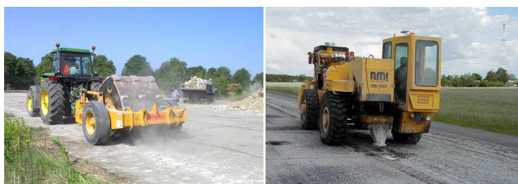
obr. 4. 12 Stroje používané pro drcení betonových krytů vozovek spol. Frekomos a Rekma
