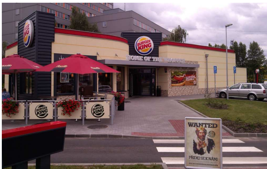
Obrázek 1 – Restaurace Drive Thru BK Chodovská (zdroj autor)
