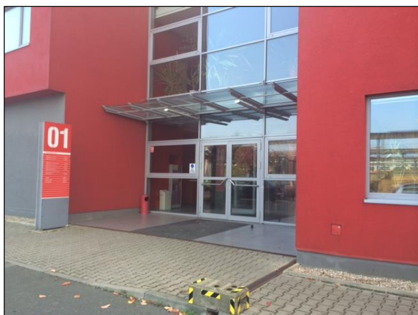
Vstup do nemovitosti
