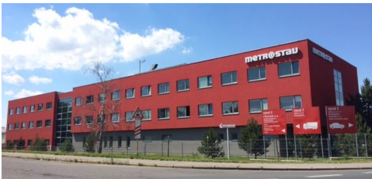
Obrázek 1. Čelní pohled vybrané nemovitosti. Zdroj: vlastní tvorba.
