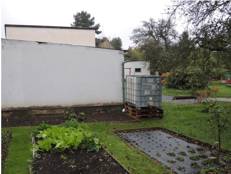
Dešťová voda dopadá na střechu garáží se využívá pro zálivku
