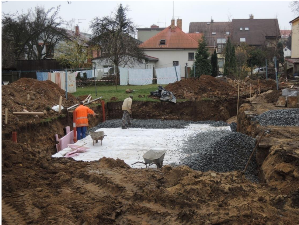
Výstavba podzemní vsakovací rýhy u P10
