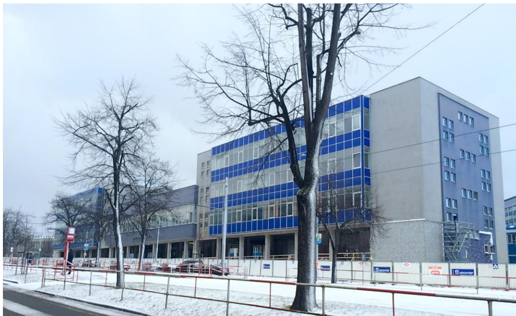
Obr. 4: CIIRC – Stav na začátku realizace
