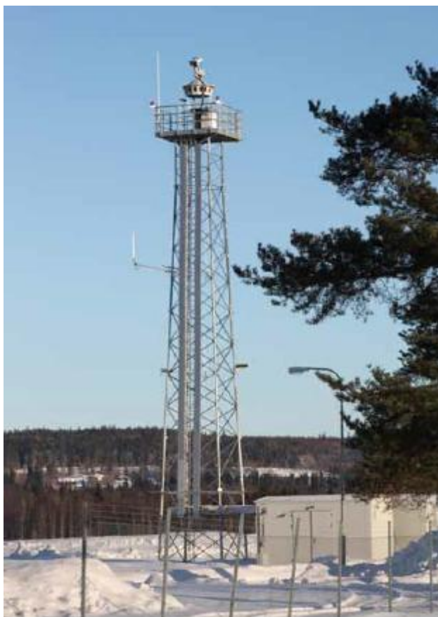
Obrázok 5 Stavba r-TWR v Orsvindiku, pod vežou je umiestnená servisná miestnosť. Zdroj: [53]
