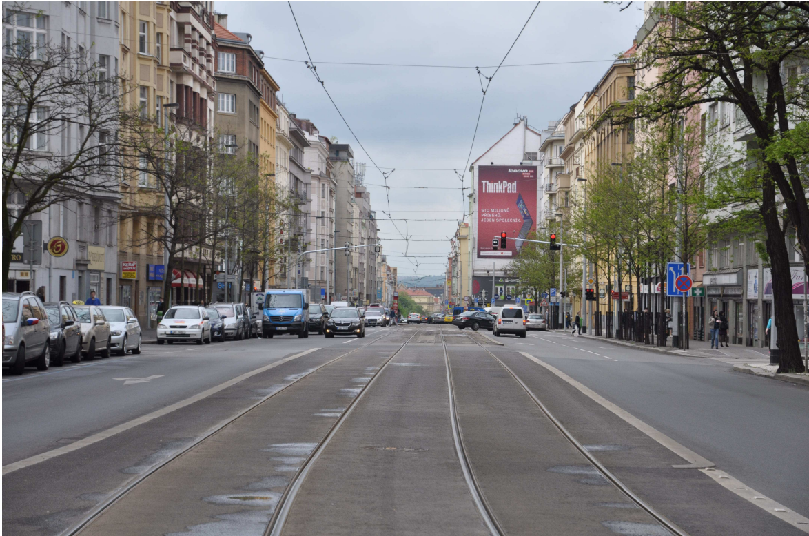
Obrázek 10 Zvýšené těleso tramvajové trati v úseku Flora - Radhošťská
