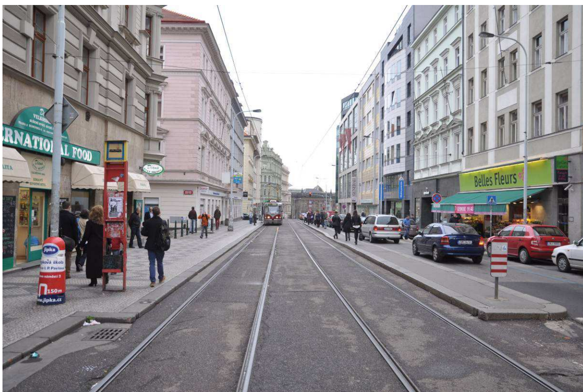
Obrázek 7 Pohled na prostor zastávek I. P. Pavlova v Bělehradské ulici
