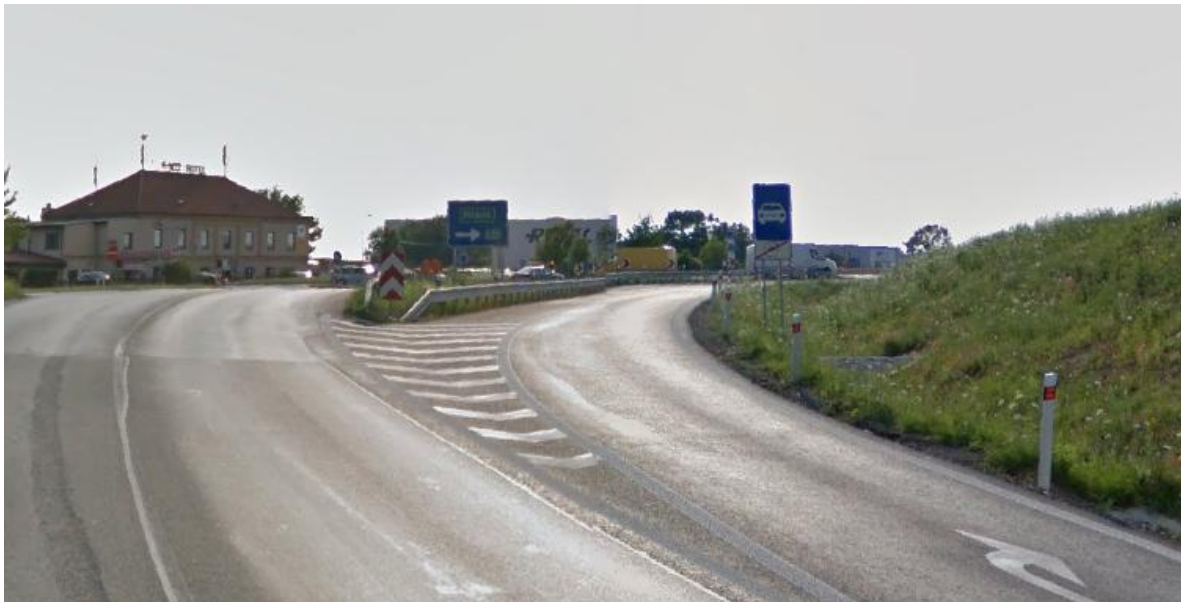
Obrázek 8: Bypass na okružní křižovatce „Na staré Poště“ [8]
