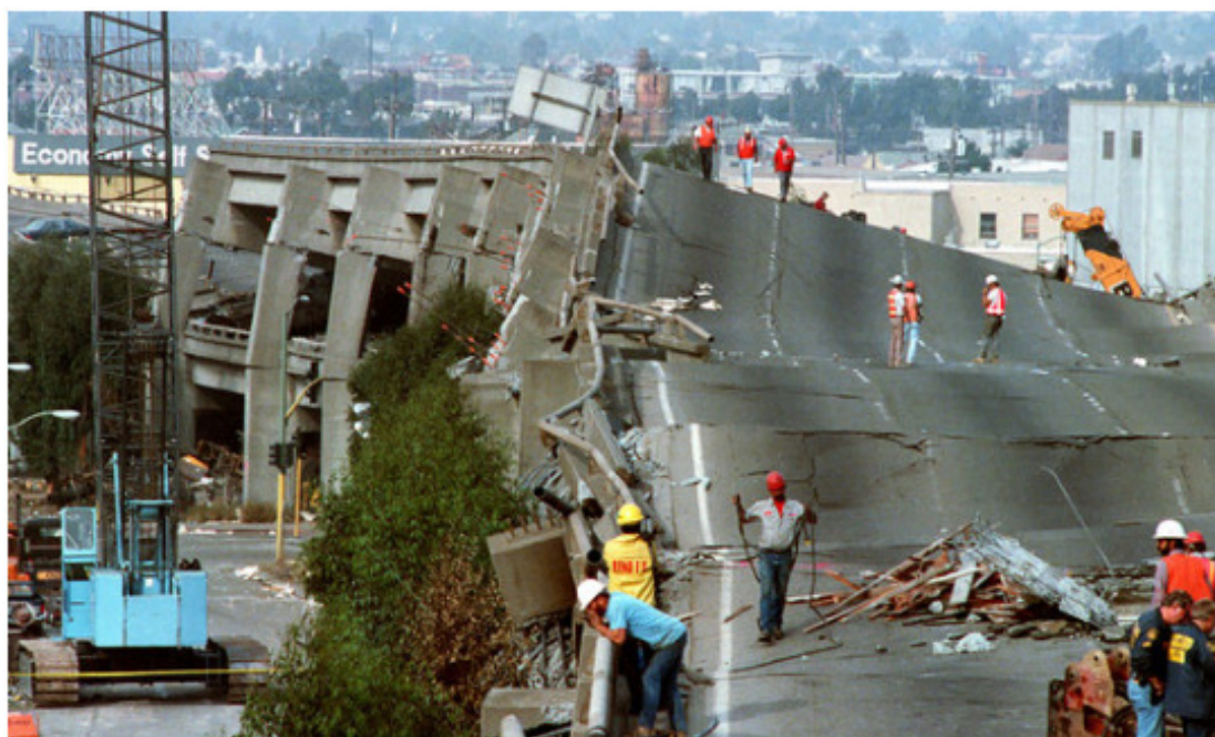
Obrázek 6: Most Cypress Street Viaduct po zemětřesení v Kalifornii v roce 1989 [11]
