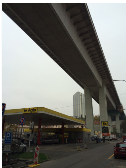
Obrázek 16: Čerpací stanice Agip pod Nuselským mostem [autor]
