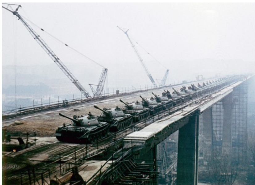
Obrázek 7: Statická zkouška Nuselského mostu [12]
