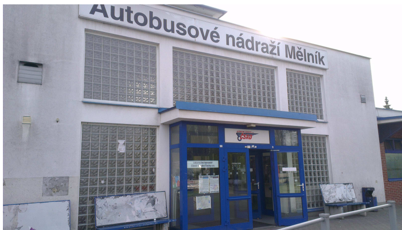
Obrázek VI: Vnější vzhled budovy AN Mělník označené pouze logem dopravce, bez loga IDS. Dvě informační přepážky uvnitř. Zdroj: autor
