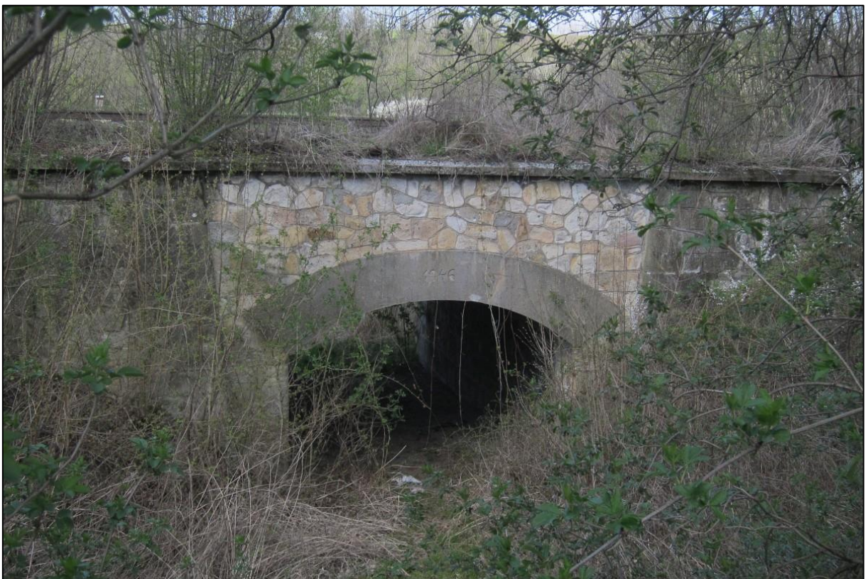
Foto. 6, Kamenný most památkově chráněný v místě uvažované zastávky Dřetovice (22.4.2015)
