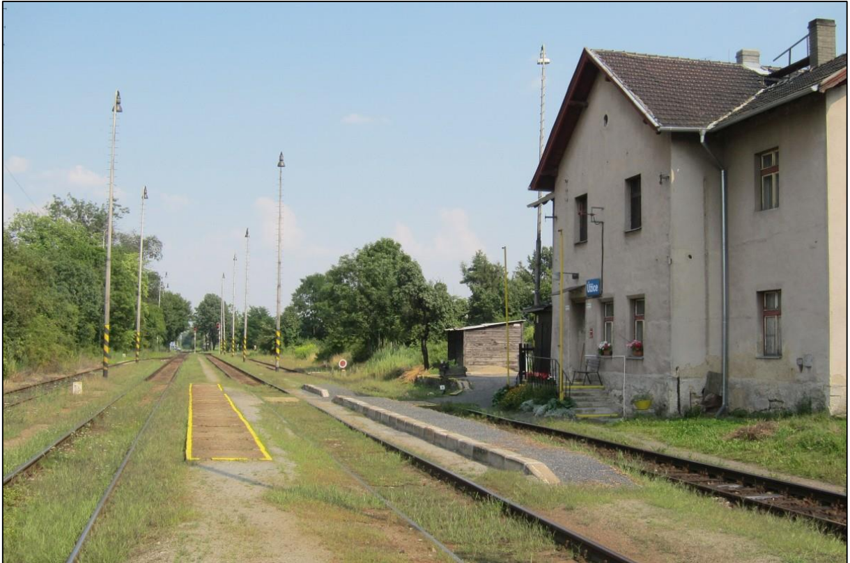
Foto. 11, Žst. Úžice, pohled k Neratovicím (27.7.2012)
