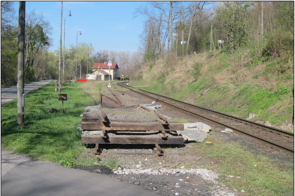
Foto. 7, Býv. žst Zákolany, místo uvažovaného ke Kladnu vysunutého nástupiště (22.4.2015)
