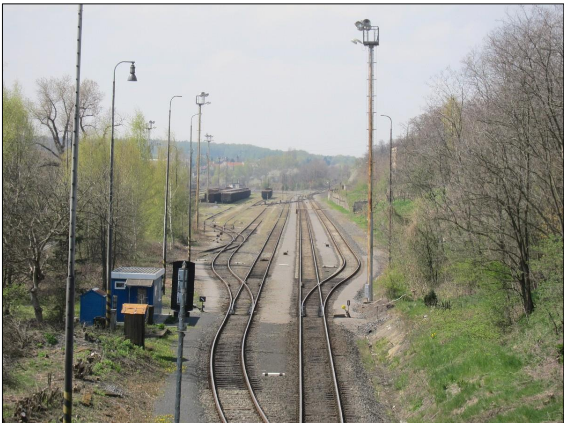
Foto. 4, Žst. Kladno-Dubí, pohled ke Kladnu (22.4.2015)
