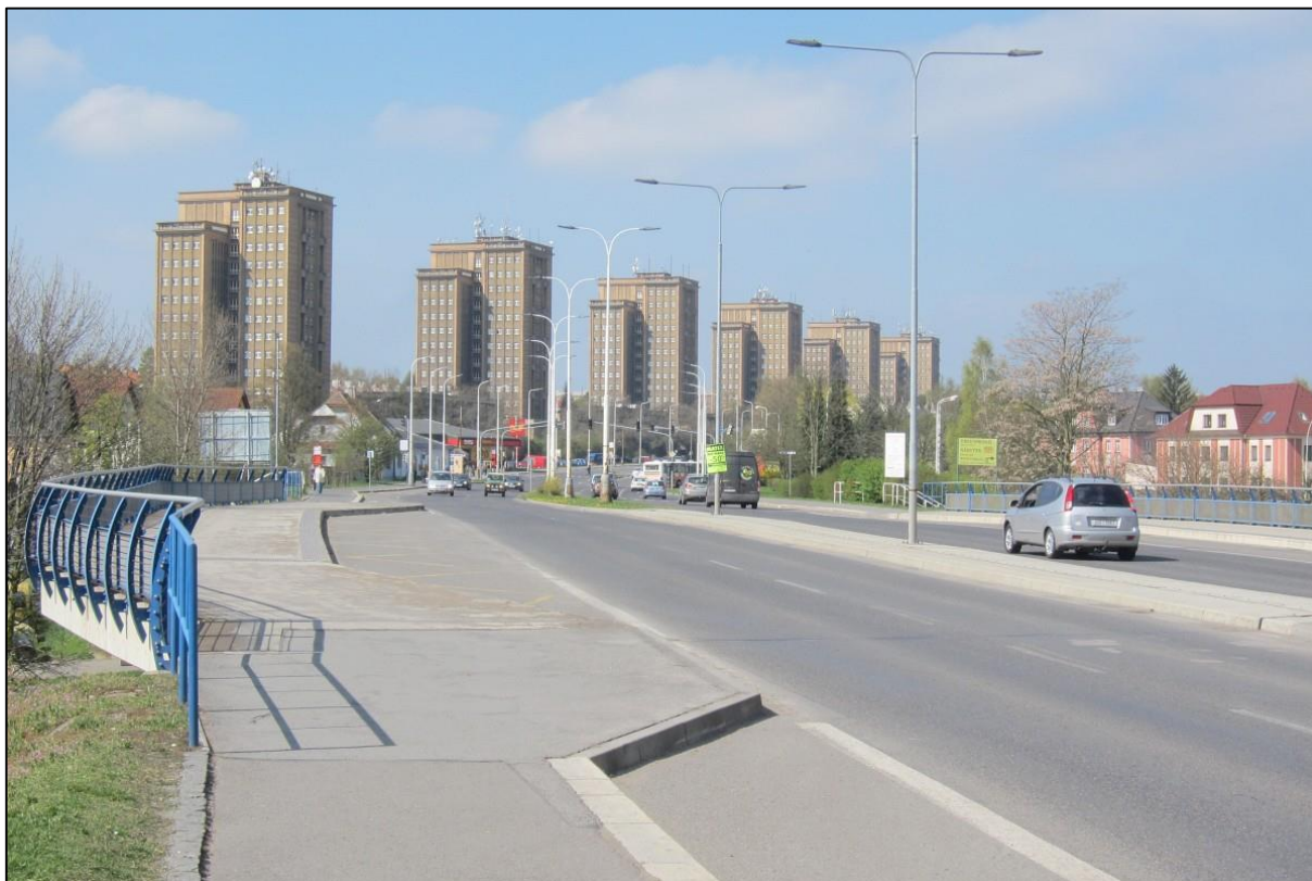
Foto. 2, Most přes trať s nevyužívanými zálivy, zast. Kladno město se nachází vpravo (22.4.2015)
