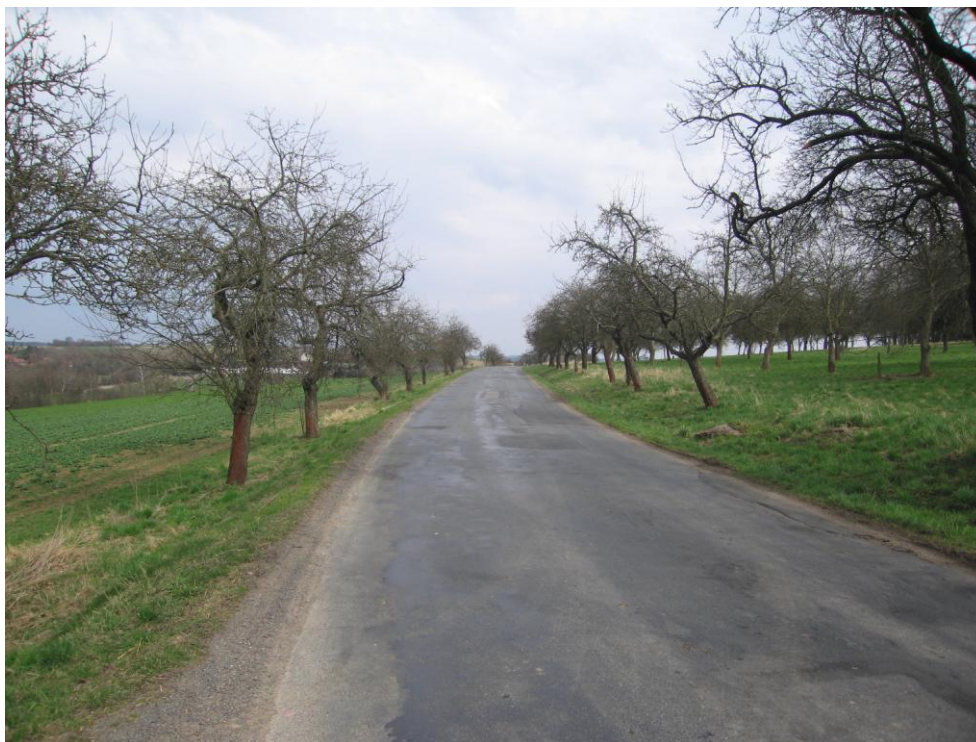
Obrázek č. 4.15: Neosvětlená silnice III/00335 – úsek Nechánice - Sulice
