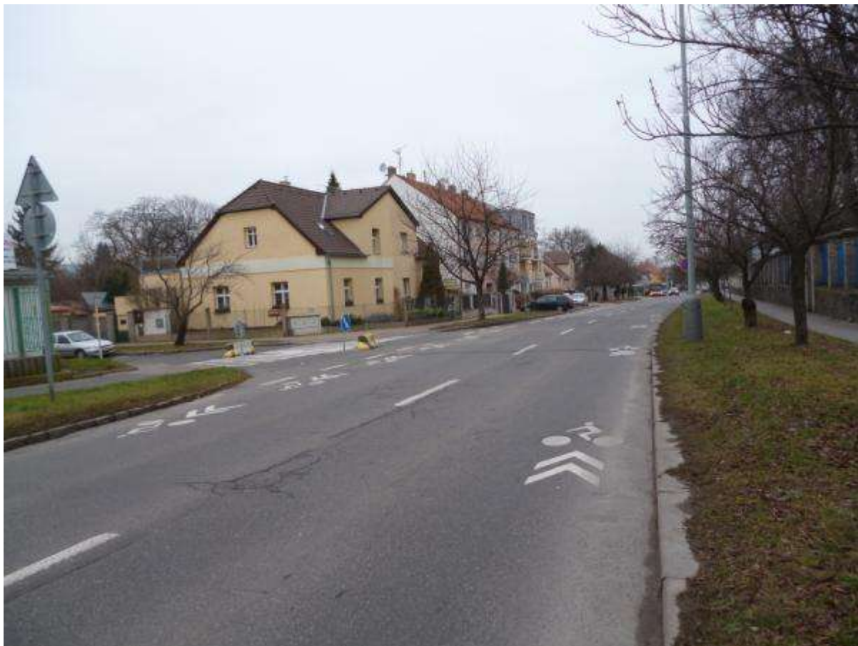
Obrázek 6: Pohled na piktogramový koridor pro cyklisty v ulici Beranových v Letňanech (foto: Archiv Jany Nejeřálové)
