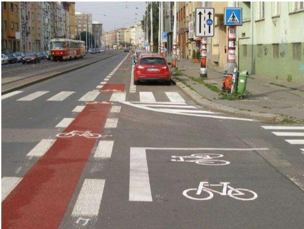
Obrázek 9: Pohled na nepřímé odbočení vlevo vyznačené v ulici V Olšínách pro odbočení do ulice V předpolí. (foto: Praha.eu portál hlavního města Prahy)
