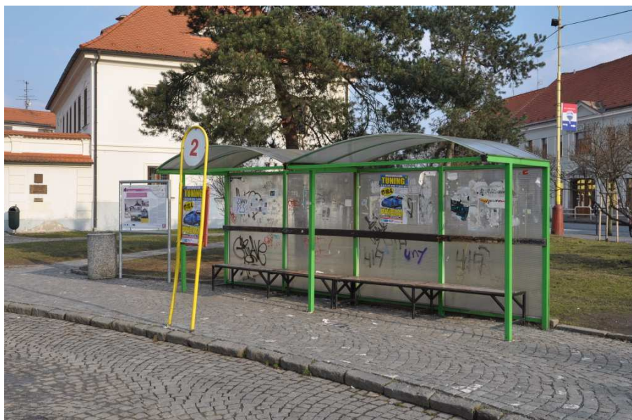
Obrázek 19 Přístřešek ve směru do Prahy
