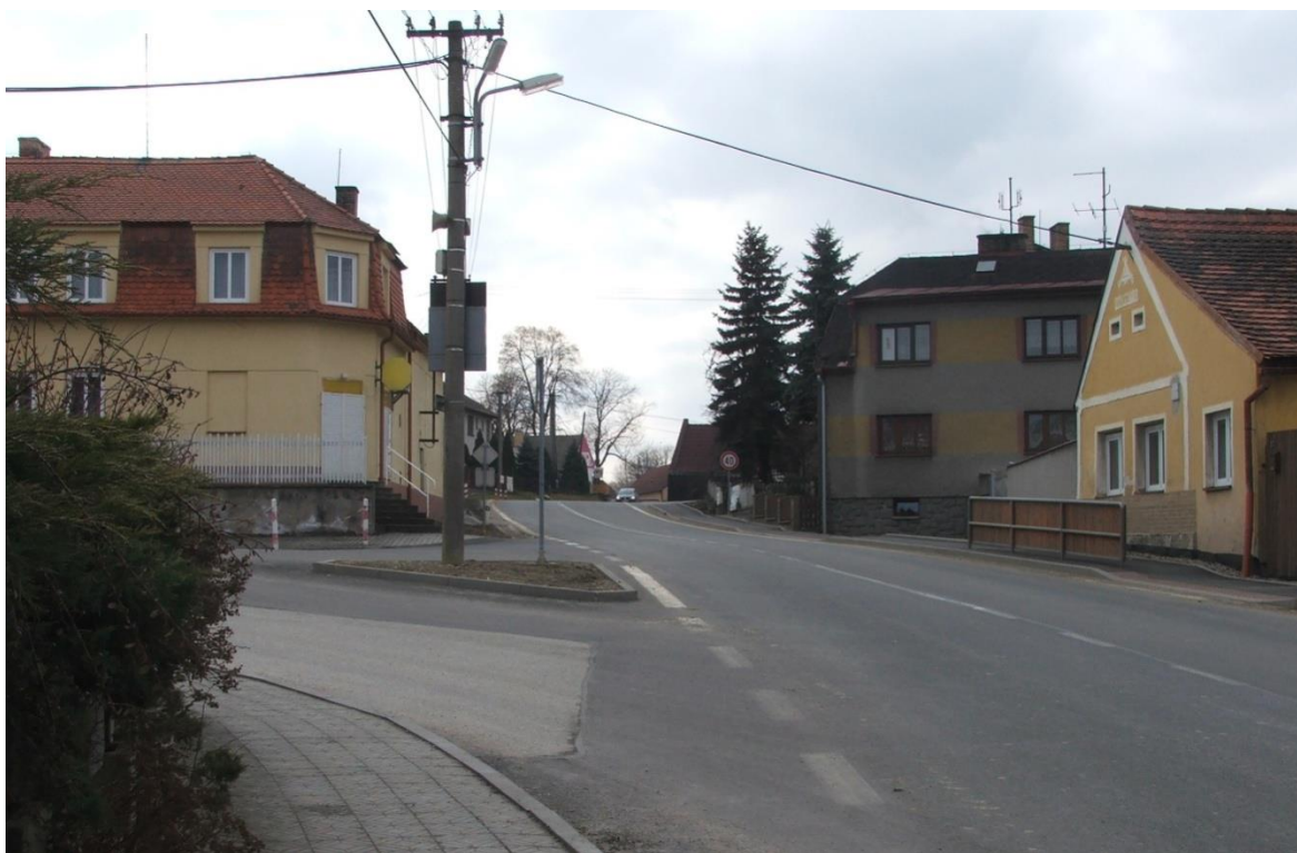
Obrázek 13: BOD B, nevhodné směrové a výškové řešení na průtahu, rychle se střídající výškové i směrové oblouky, pohled směr Netolice
