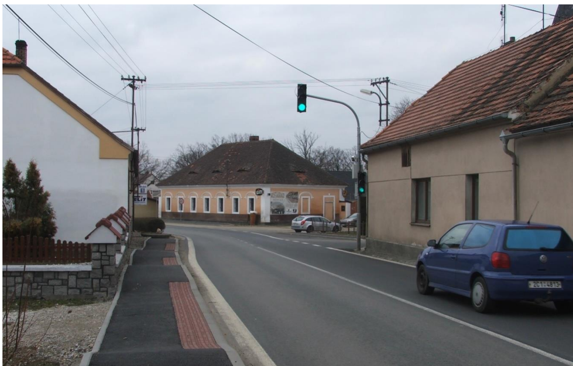
Obrázek 11: BOD A, SSZ pro zpomalení rychle jedoucích vozidel a na nepřehledný horizont navazující levostranný oblouk, pohled směr Netolice
