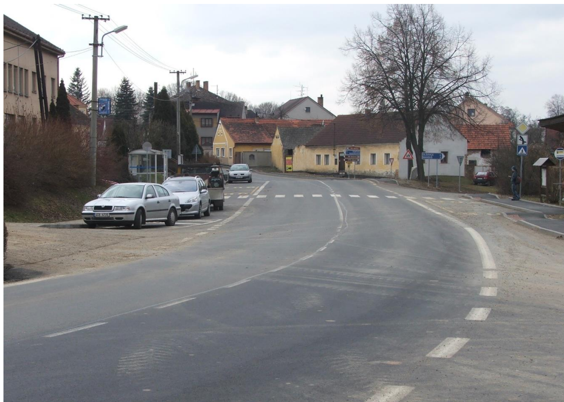
Obrázek 12: Průjezd centrální oblastí Němčic, pohled směr Netolice
