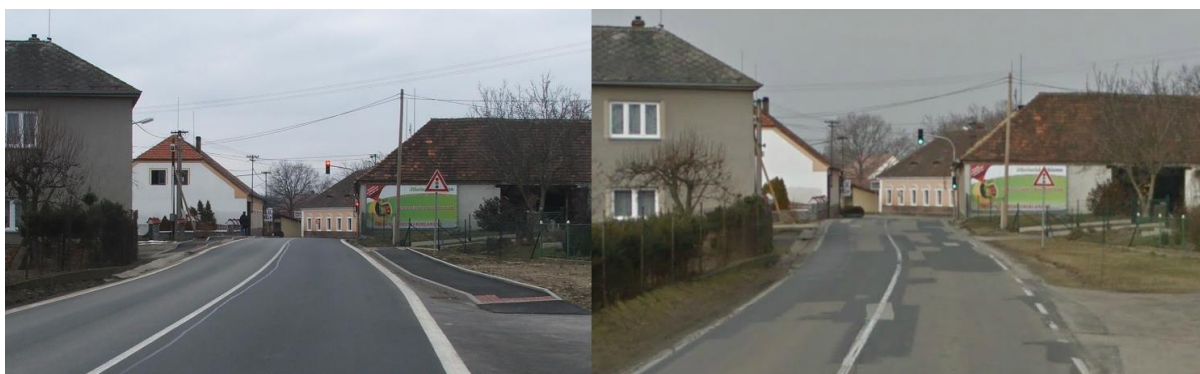
Obrázek 7: Průtah po rekonstrukci, březen 2013
