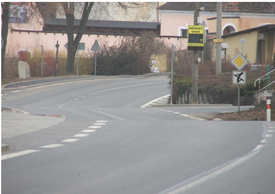
Obrázek 14: BOD B , nevhodné směrové a výškové řešení na průtahu, pohled z druhé strany směr České Budějovice
