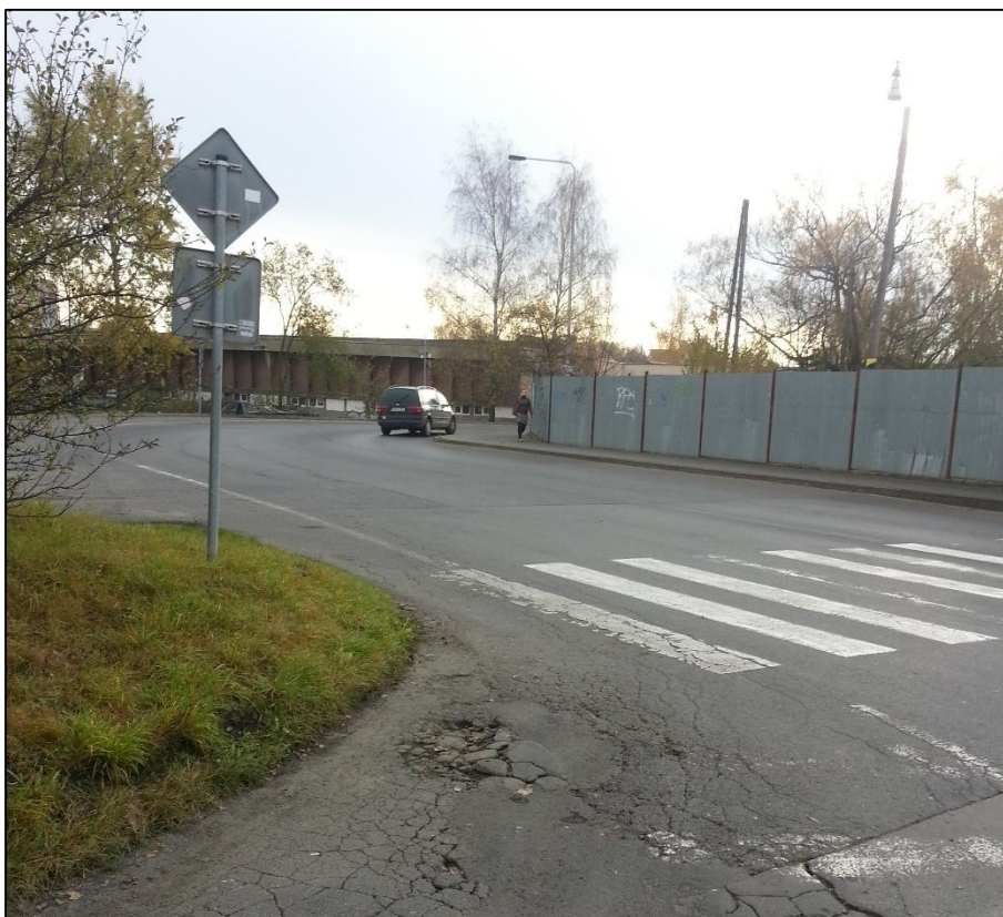
1- Pohled na vjezd ramene V1 (ul. M.Horákové)
