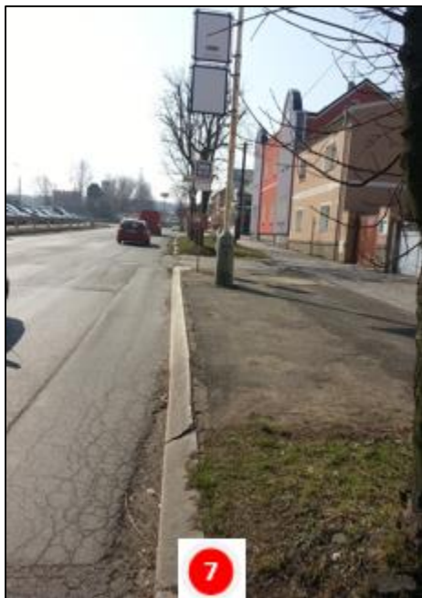
Obrázek 14 - Pohled na současný stav autobusové zastávky
