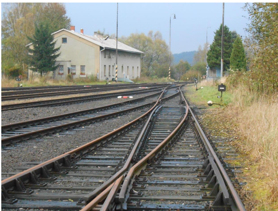
Obrázek 26 – Großschönauské zhlaví, v popředí jednoduchá výhybka 21 JS49-1:9-190
