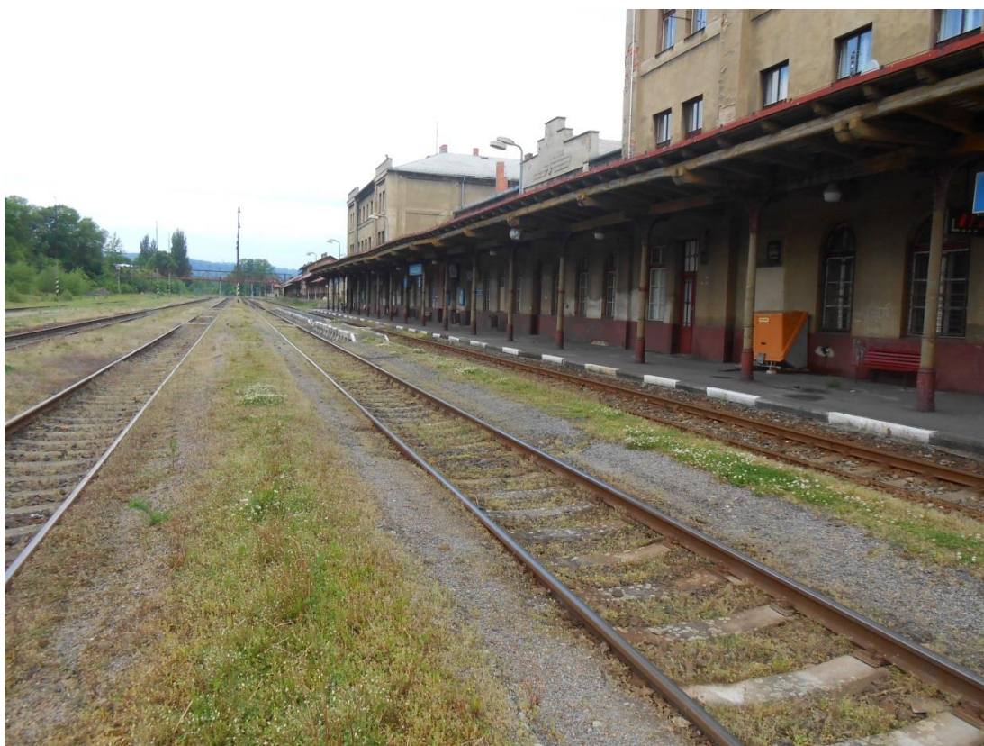
Obrázek 16 – Nástupiště ve stanici (I. a II. jsou z konstrukce TISCHER, III. a IV. Jsou sypaná)
