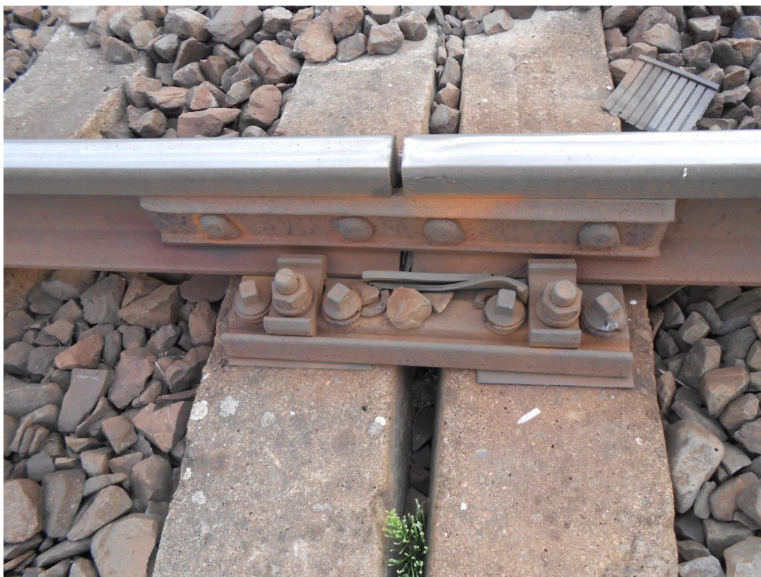
Obrázek 14 – Spojení kolejnicových pásů pomocí montovaného styku
