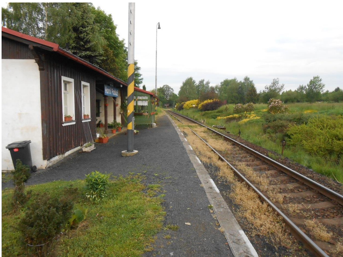
Obrázek 6 – Zastávka Horní Podluží s nástupištěm z konstrukce TISCHER (v km 3,310)
