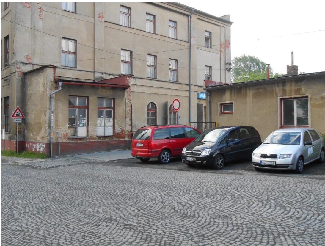
Obrázek 31 – Improvizované parkování typu P+R u západního křídla výpravní budovy
