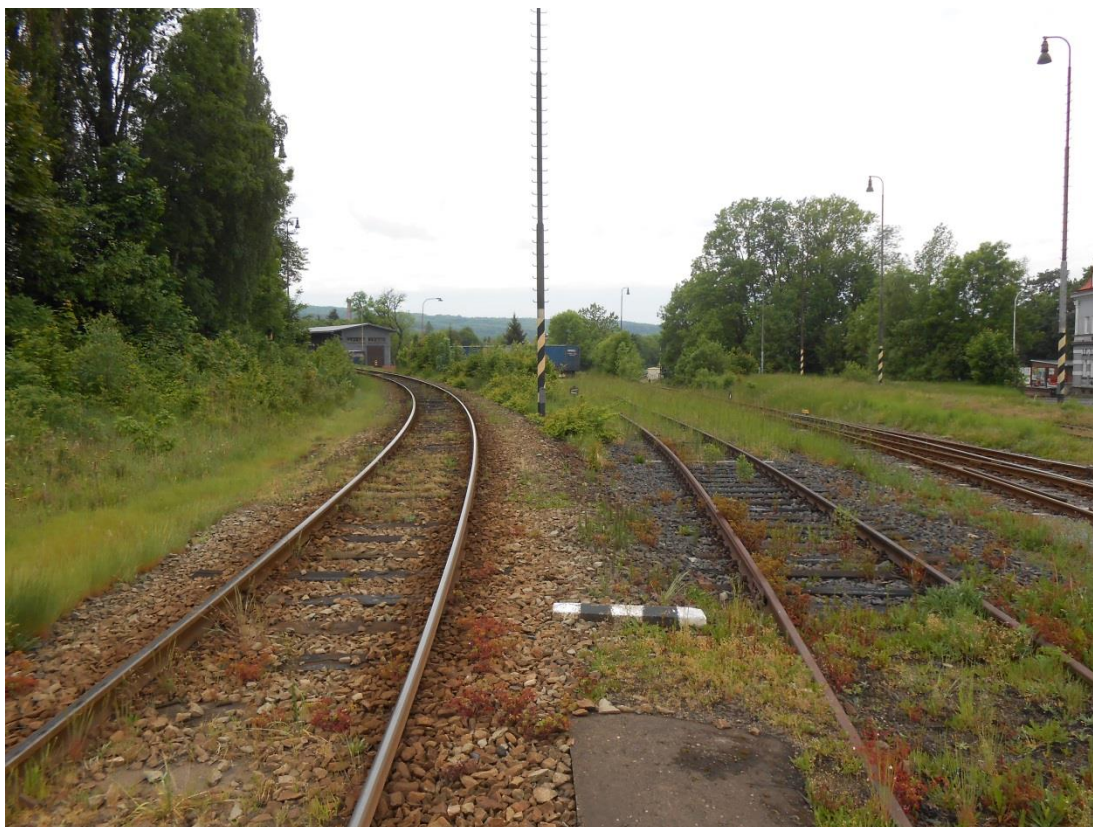
Obrázek 17 – Rybnišťské zhlaví (vlevo odjezdová kolej směr Rybniště, vpravo odjezdová kolej směr Seifhennersdorf)
