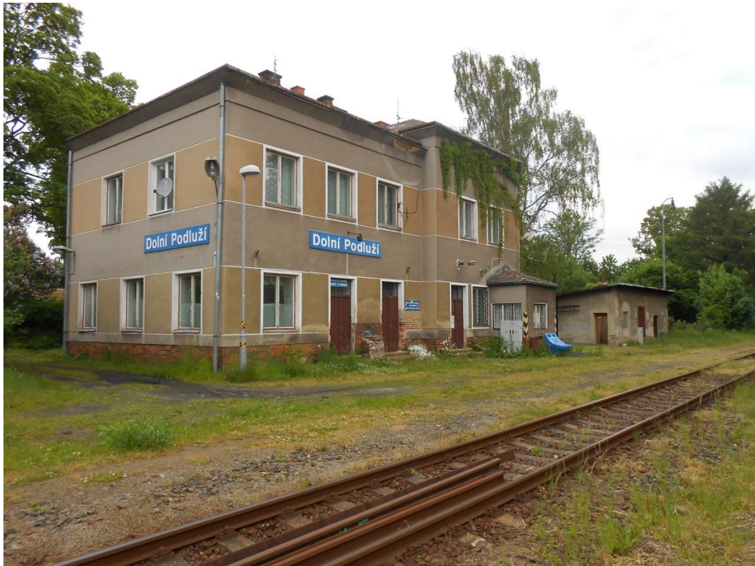
Obrázek 11 – Zastávka a nákladíště Dolní Podluží se sypaným nástupištěm v km 8,290
