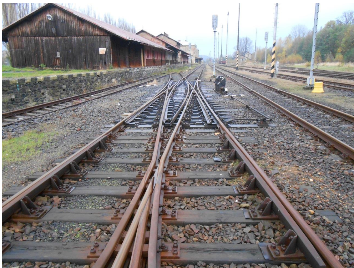
Obrázek 20 – Křižovatková výhybka 10a – CS49-1:9-190
