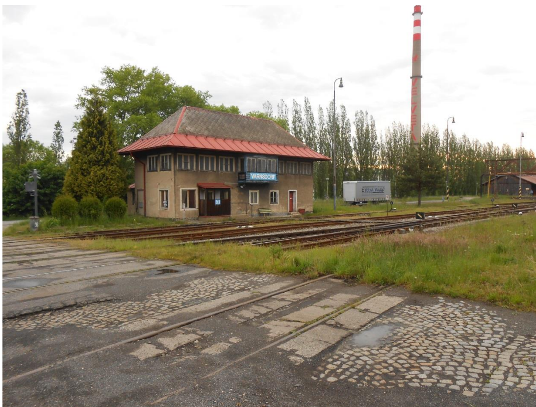
Obrázek 18 – Stanoviště výhybkáře St. 1 u rybnišťského zhlaví
