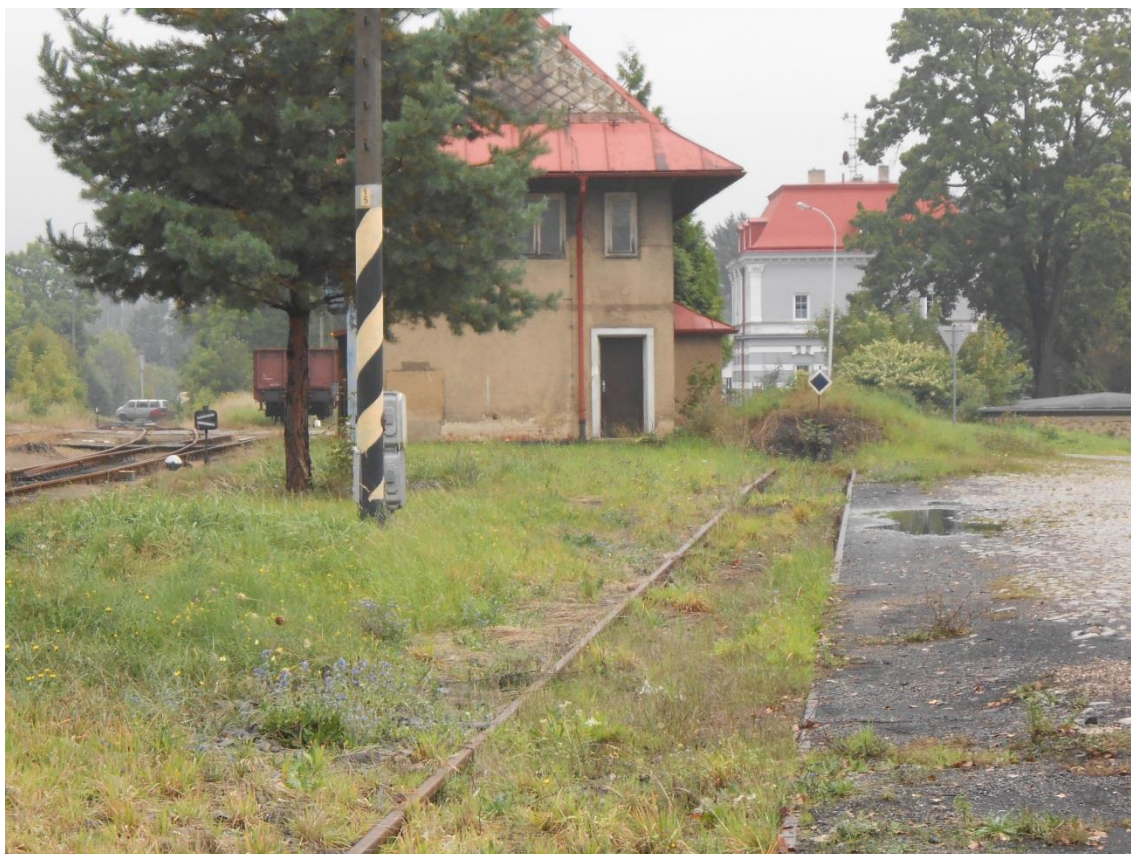
Obrázek 21 – Kusá manipulační kolej 7a o užité délce 87 metrů
