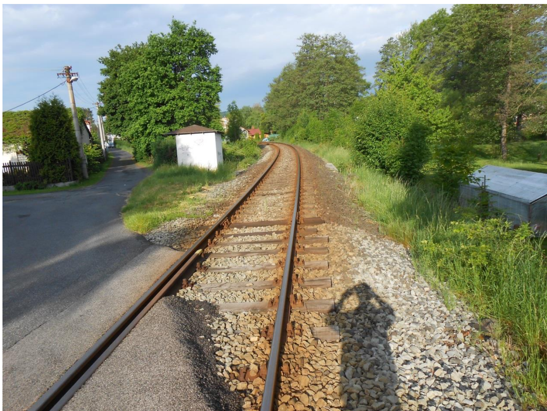
Obrázek 12 – Směrový oblouk v km 9,508 o poloměru 282 metrů, který je velkým omezením v rámci možnosti zvýšení rychlosti
