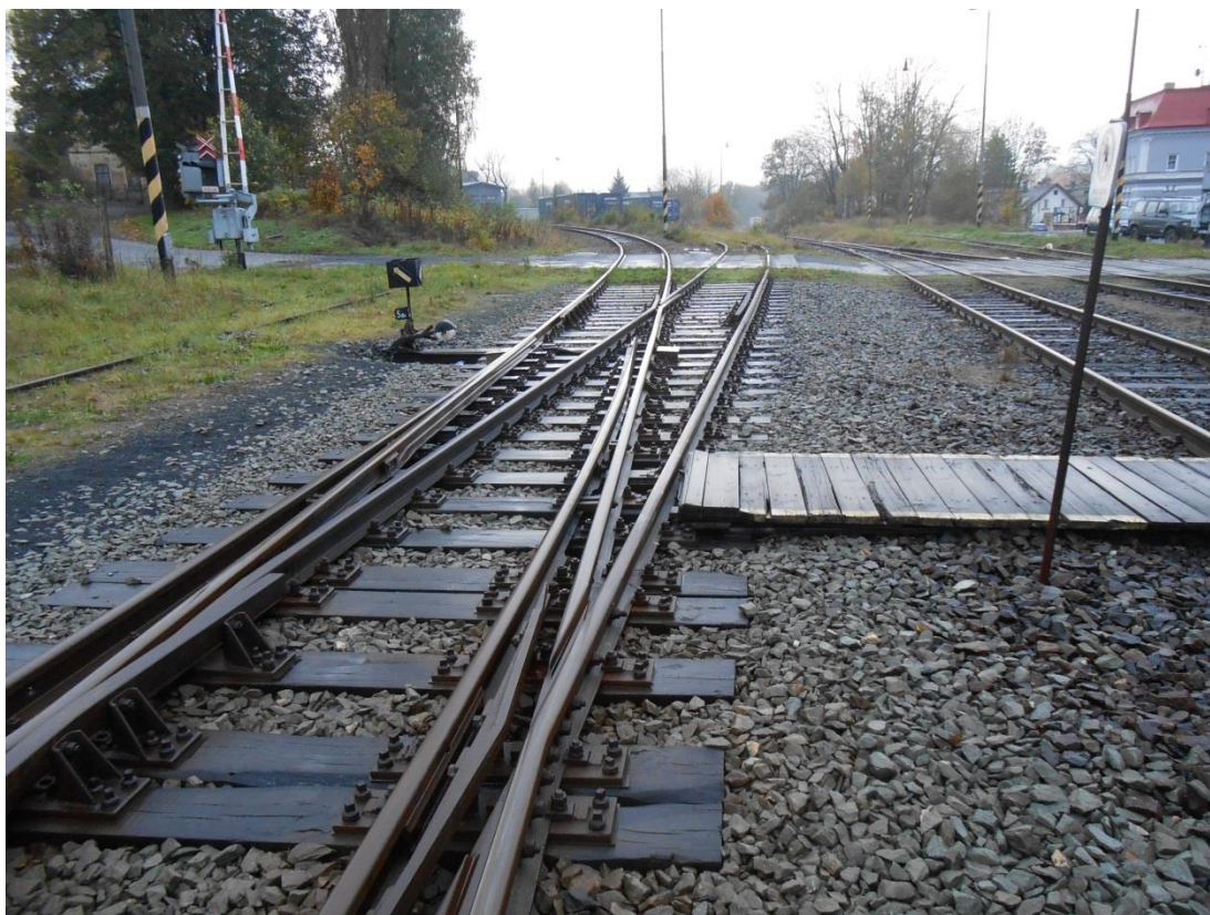
Obrázek 19 – Křižovatková výhybka 5a – BS49-1:9-190
