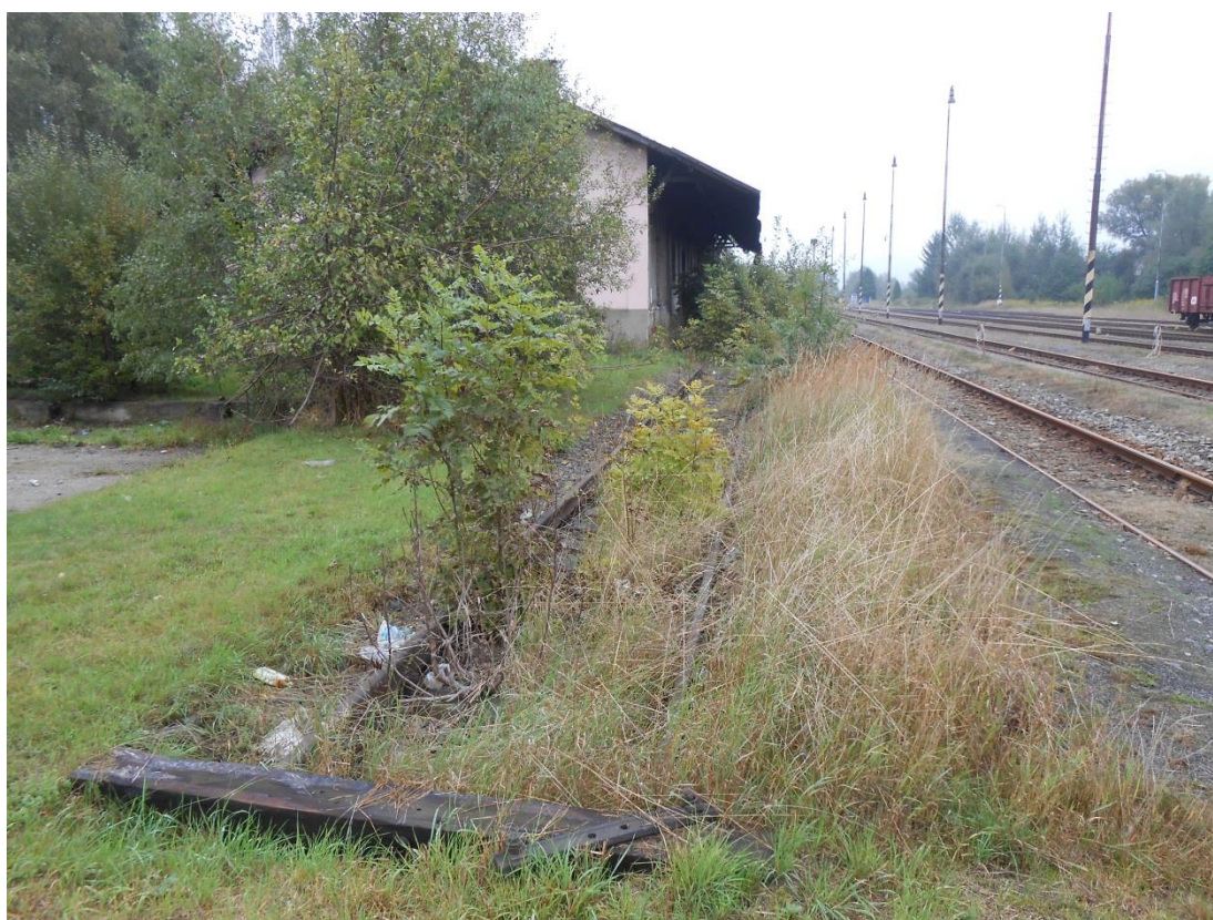
Obrázek 22 – Kusá manipulační kolej 7c o užité délce 167 metrů
