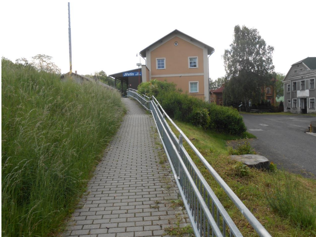
Obrázek 10 – Zrekonstruovaný bezbariérový přístup na nástupiště v zastávce Jiretín
