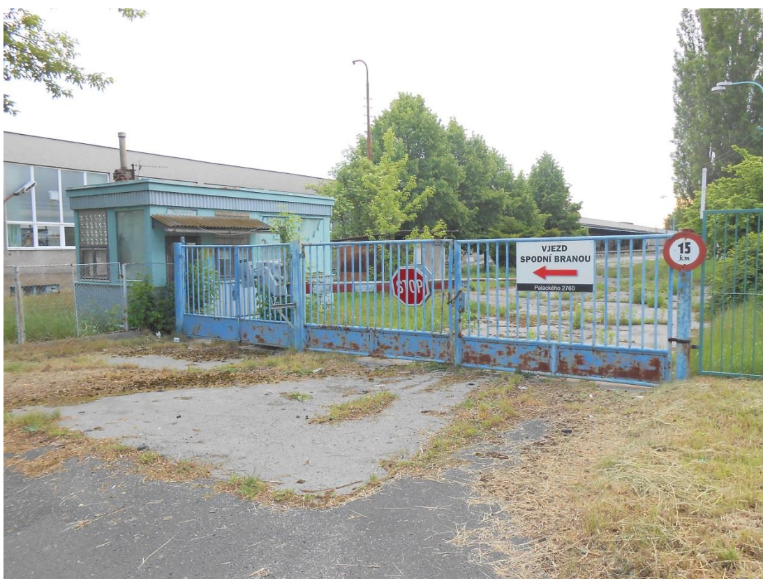
Obrázek 30 – Vjezd do průmyslového areálu Velvety zaústěný do prostoru přednádraží
