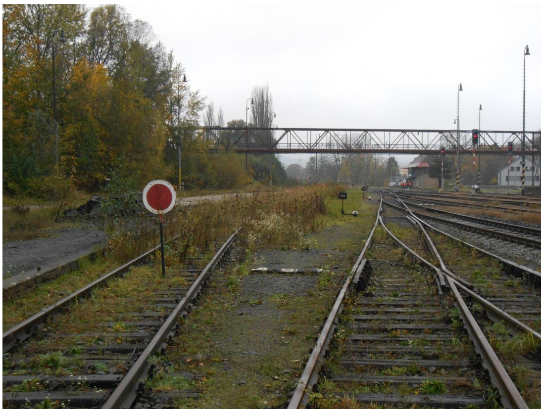
Obrázek 25 - Vlevo vyloučená manipulační kolej 10 a, vpravo jednoduchá výhybka 14 – JS49-1:7,5-190
