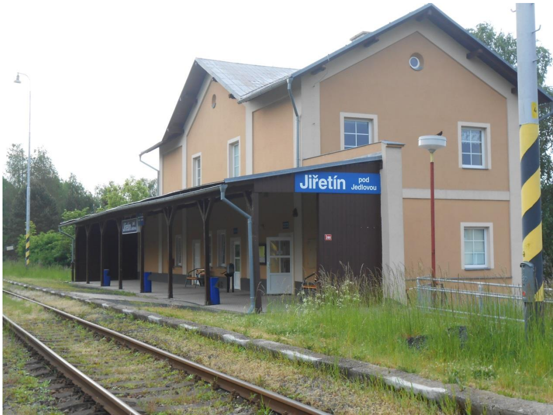
Obrázek 9 – Zastávka a stanoviště hláskáře Jiretín pod Jedlovou v km 5,027 s nástupištěm z konstrukce TISCHER
