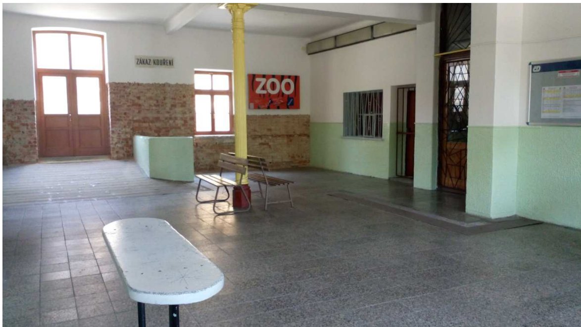
Prostor výpravní budovy - čekárna
