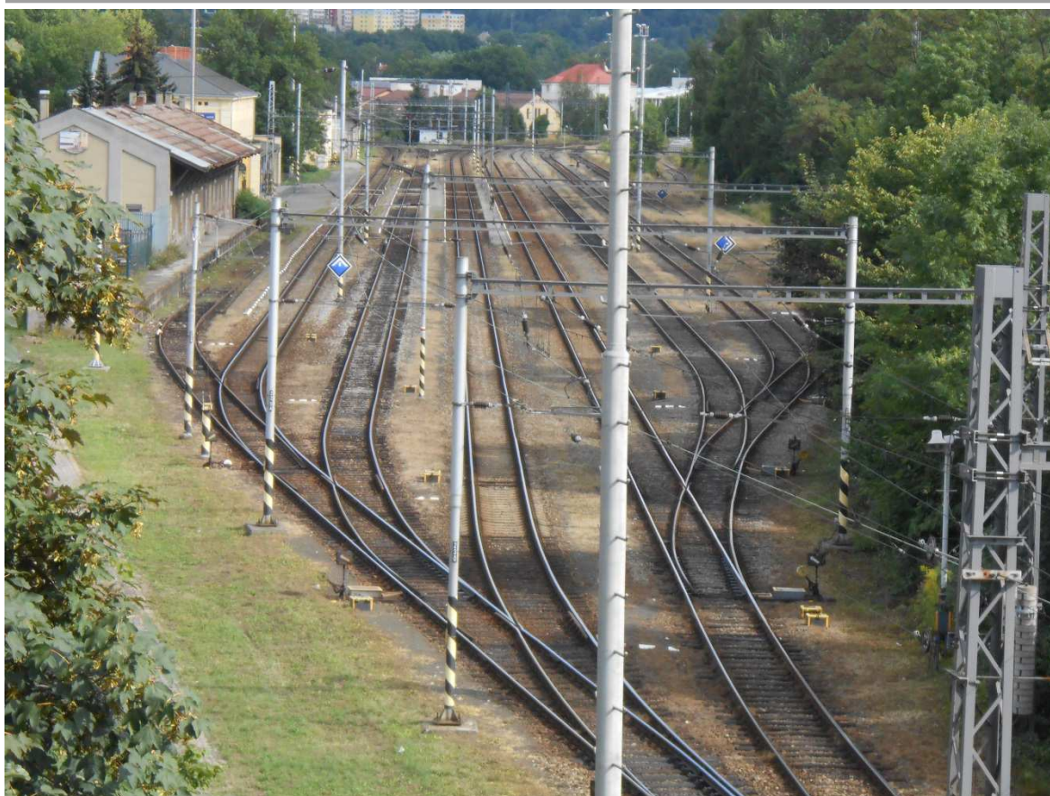
Obr. 6 - Foto zhlaví stanice Děčín východ horní n. ve směru Děčín hl. n. - Rumburk
