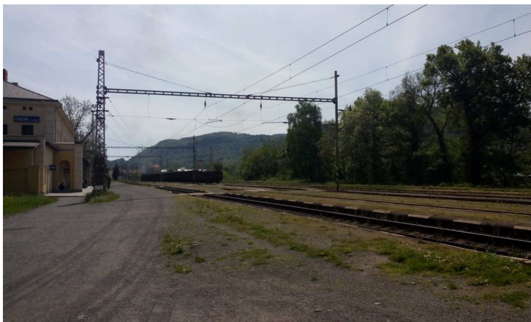
Stávající nástupiště u staniční koleje 105
