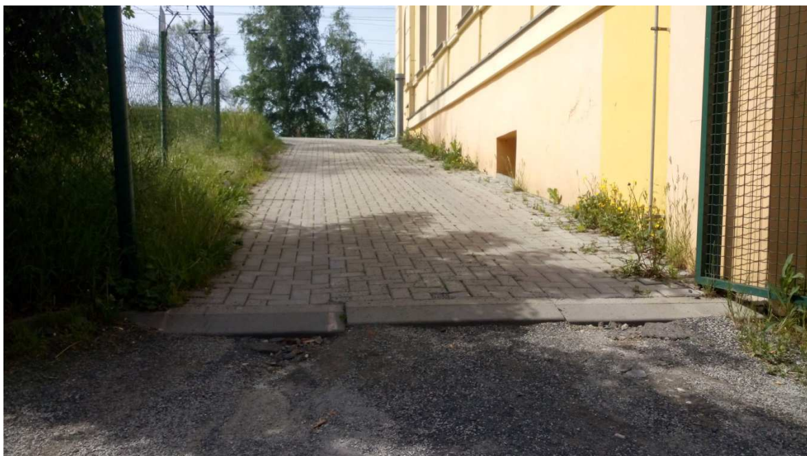
Vchod do prostoru stanice z prostoru přednádraží
