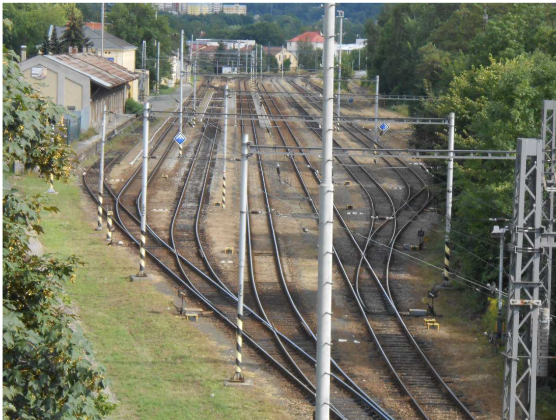
Prostor kolejíště Děčín východ horní nádraží
