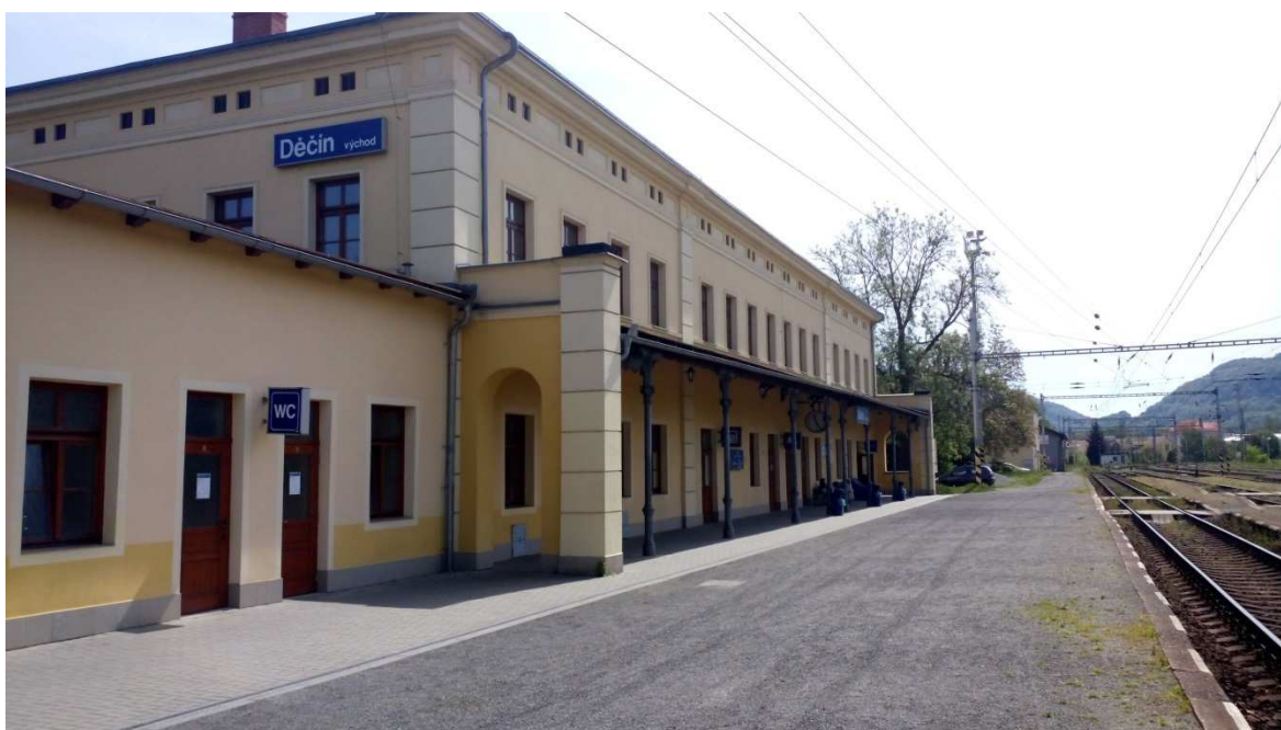
Výpravní budova pohled z prvního nástupiště
