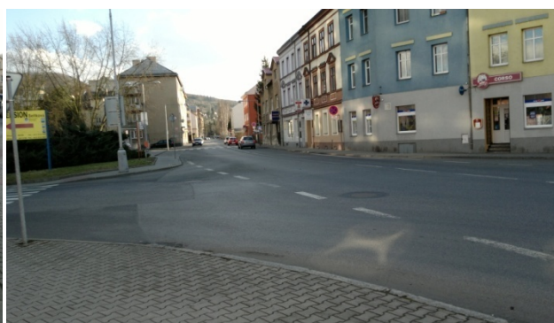
Obrázek 18 Pohled na napojení větve B
