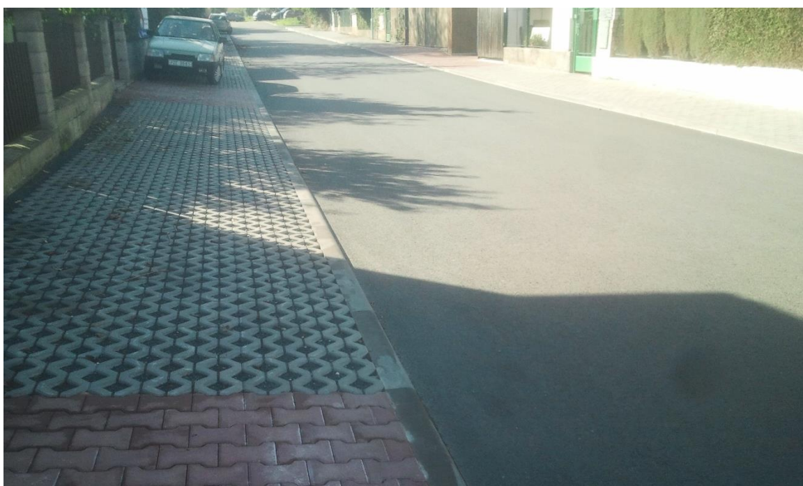
Obr. 17: Rekonstrukce ulic, stav po rekonstrukci, příklad (zdroj: autor)
