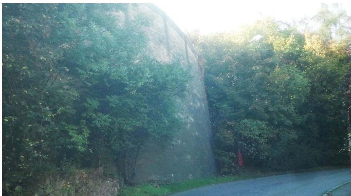
Obr. 11: Točky, konstrukční zeď (zdroj: autor)
