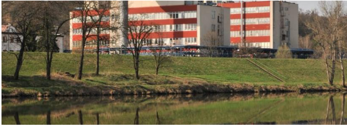
Obr. 29: Protipovodňová hráz, pohled (zdroj: https://www.google.cz/maps/@50.158632,14.403023,5a,42.2y/data=!3m5!1e2!3m3!1s63088144!2e1!3e10?hl=cs )
