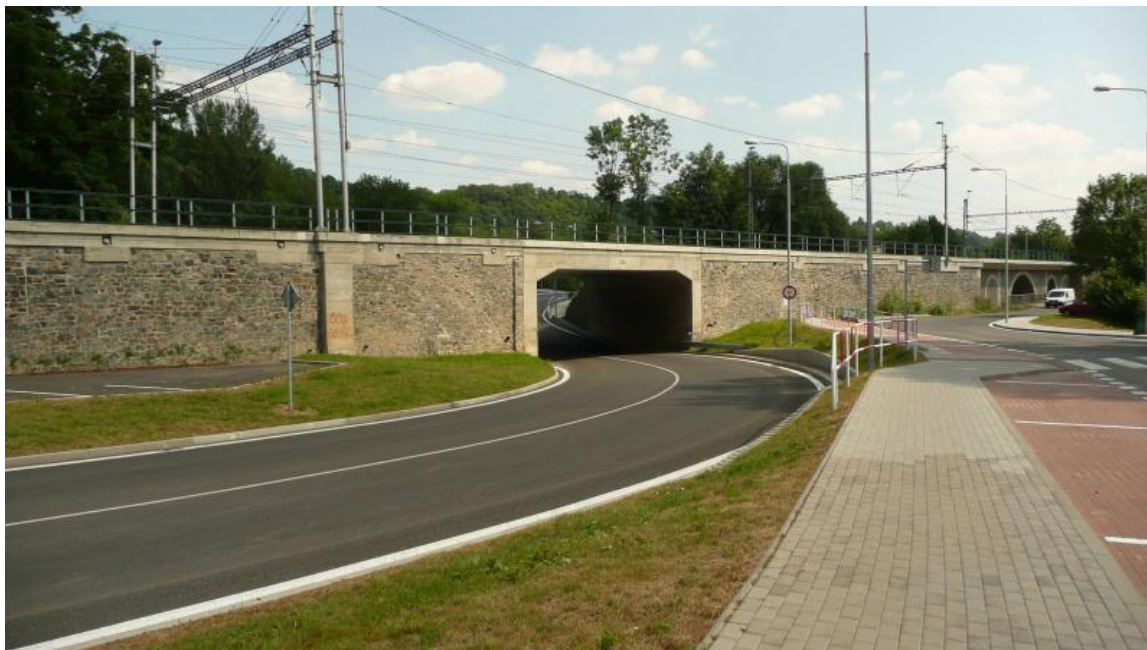
Obr. 9: Podjezd pod železniční tratí (zdroj: http://www.af-cityplan.cz/res/dwe-files/n_1404041831.jpg )
