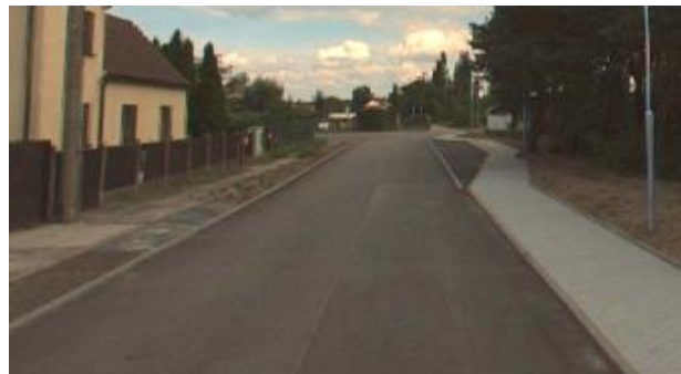
Obrázok 72: Ulica Třebízského po rekonštrukcii pred križovatkou Okružní (Zdroj: www.google.com/maps )
