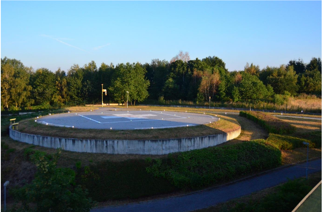
Obrázek 8: Heliport Domažlice-nemocnice a jeho světelné a přibližovací zařízení (APAPI) (Zdroj: vlastní)
