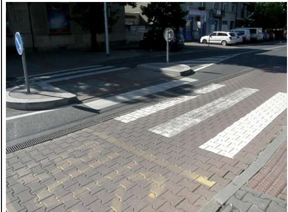
Obrázek 7 - přechod pro chodce chráněný ostrůvkem, zdroj A. Sodomková
