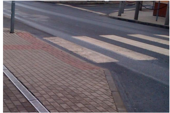
Obrázek 13 - přechod pro chodce s vysazenou chodníkovou plochou, zdroj J. Jíšová
