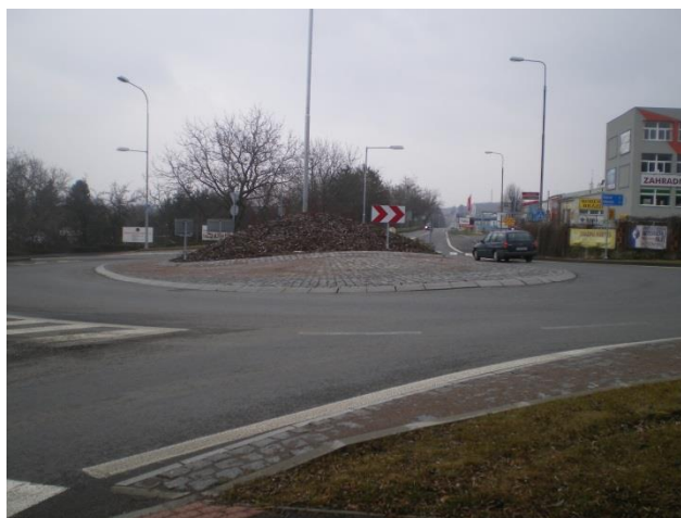
Obrázek 7 Nově rekonstruovaná okružní křižovatka, [Autor]
