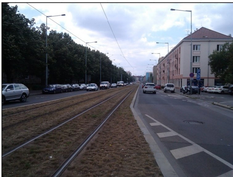
Obrázek 4: Tramvajová trať v západní části Černokostelecké ulice
