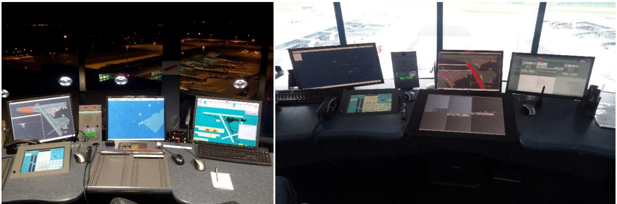
Obrázek 19 Instalace monitoru na stanovišti TWR Ruzyně
