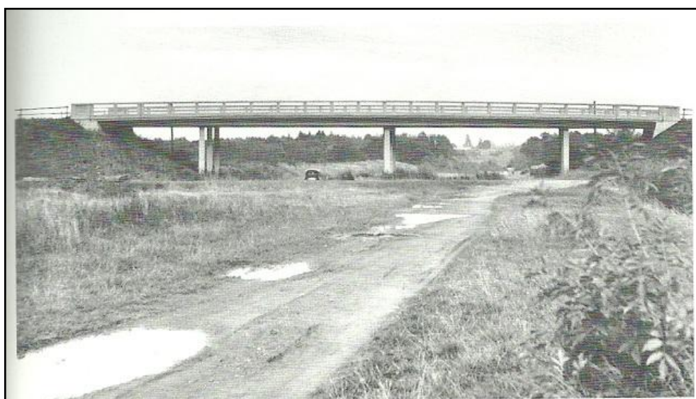
Obrázek 10: 5 km dálnice D1 ve směru na Brno v šedesátých letech [24]
