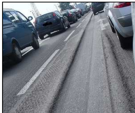
Obrázek 21: Vyjeté koleje, zdroj: [17]
