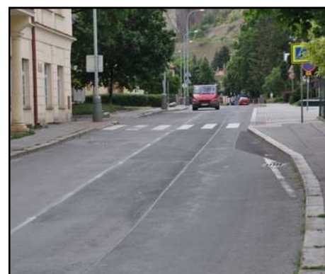
Obrázek 33: Zúžení silnice, zdroj: [26]
