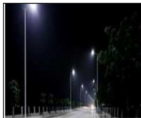
Obrázek 28: Osvětlení komunikace, zdroj: [23]
