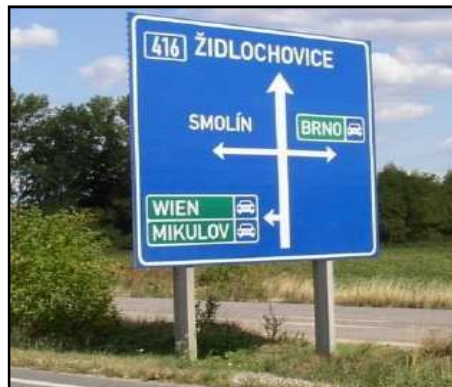
Obrázek 30: Nebezpečné sloupky DZ, zdroj: [10]
