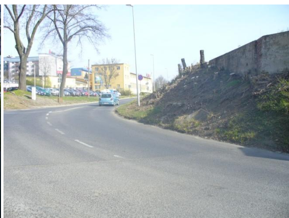
Obrázek 16 – Oddělený železniční násyp
