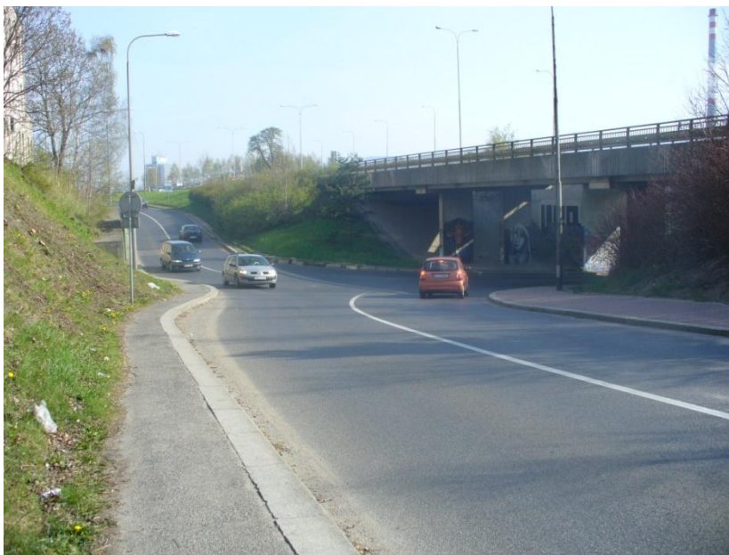
Obrázek 29 – Křižovatka z ulice Doubská (foto autor)
