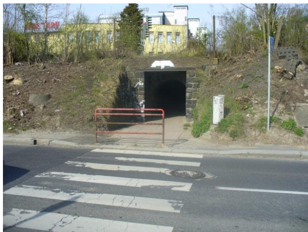
Obrázek 30 – Zábradlí v místě přechodu pro chodce v ulici Doubská (foto autor)
