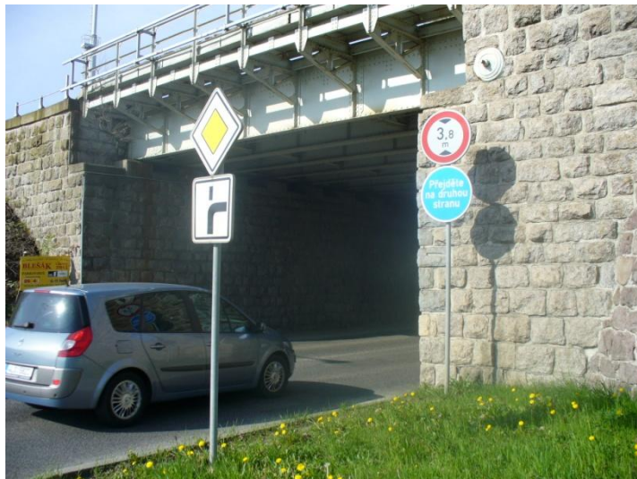
Obrázek 14 – Svislé dopravní značení před podjezdem směrem k Home Credit aréně (foto autor)
