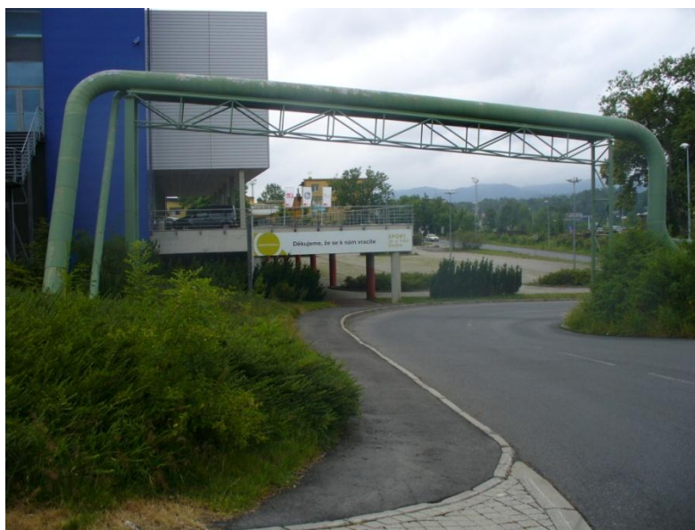
Obrázek 18 – Pohled na ulici Máchova před pravotočivým obloukem (foto autor)
