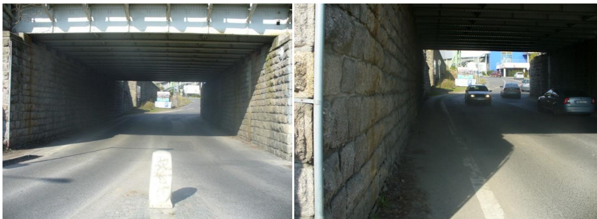
Obrázek 12 - Podjezd v ulici Klatovská (foto autor)
